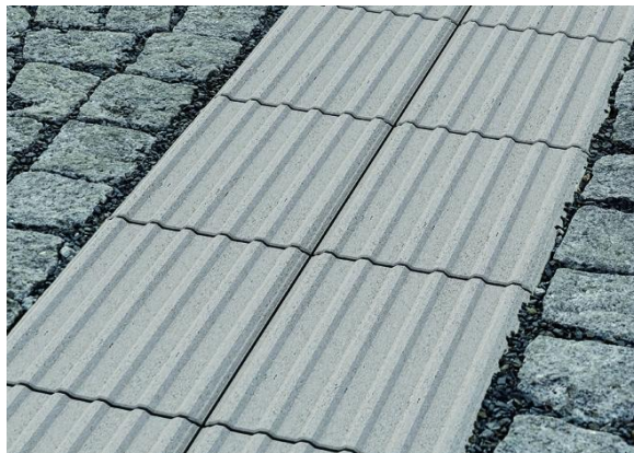
Obrázek 2 - Umělá vodící linie (drážky) v exteriéru [27]
