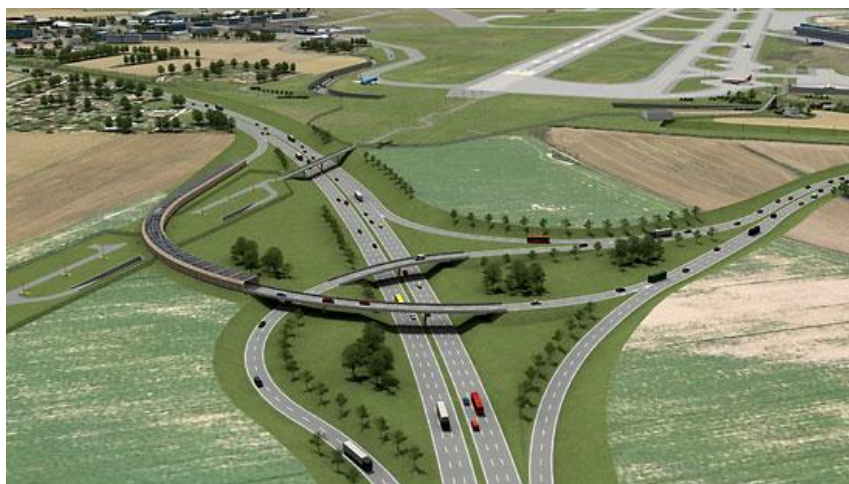
Obrázek 23. Pohled na RESA RWY 24L a silnici R7 [1]
