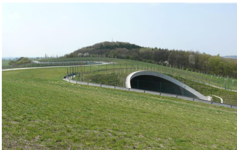
Obrázek č. 8 Stav ekoduktu Žehuň ke dni 10.4.2009 [12]
