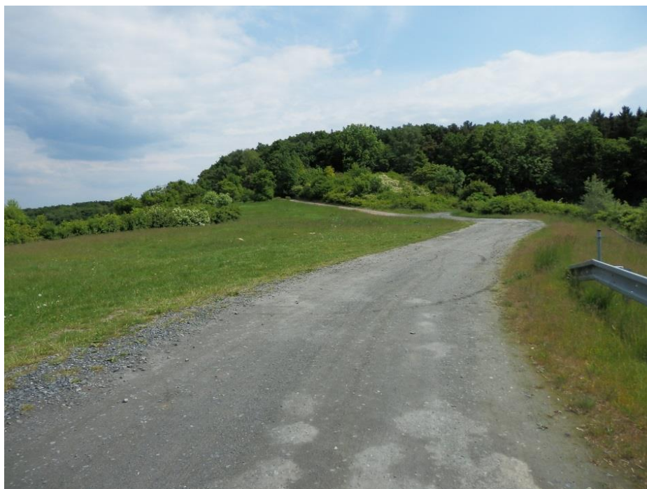
Obrázek č. 9 Stav ekoduktu Žehuň ke dni 28.7.2015 [autor]
