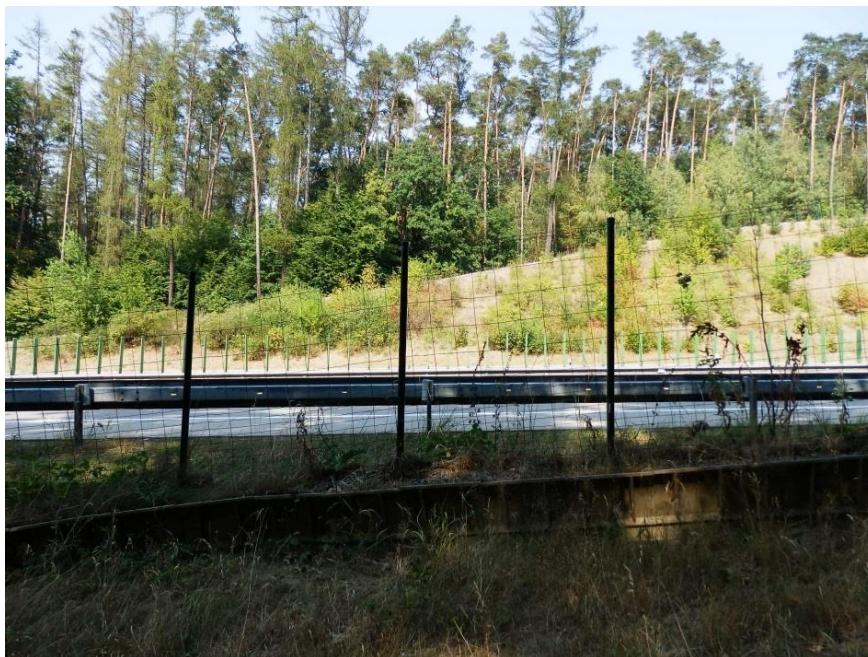
Obrázek č. 13 Oplocení komunikace a zábrana pro malé živočichy [autor]
