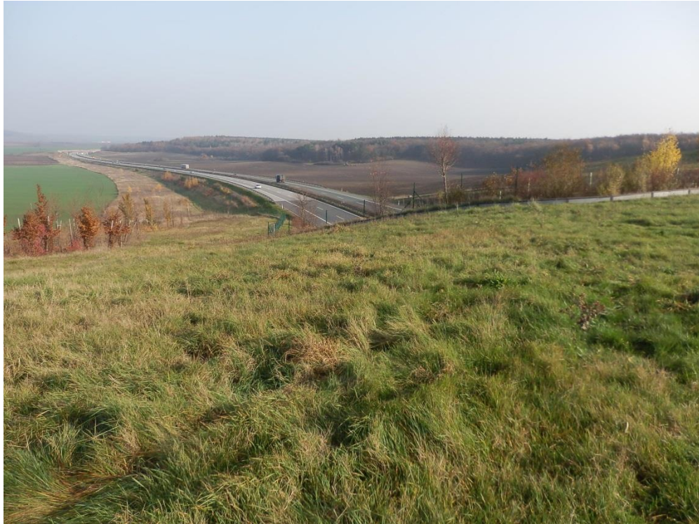
Obrázek č. 18 Pohled z měřicího bodu 3 na D11 po směru staničení [autor]
