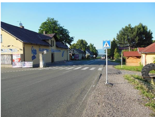
Obrázek 4.2: přechod pro chodce v obci Horka u Staré Paky, zdroj: autor, 3.7.2015
