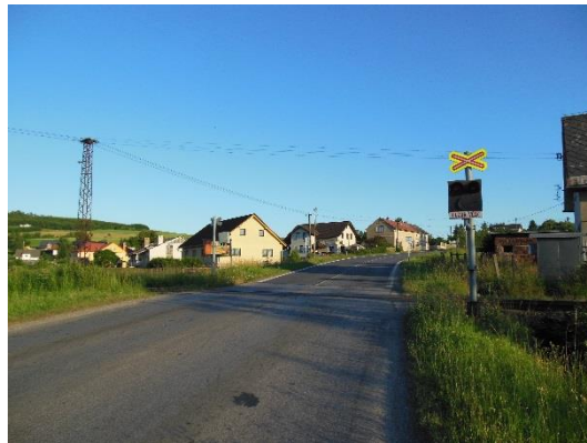
Obrázek 4.5: Železniční přejezd Martinice v Krkonoších, zdroj: autor, 3.7.2015
