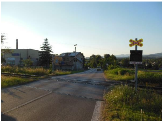
Obrázek 4.6: Železniční přejezd Martinice v Krkonoších, zdroj: autor, 3.7.2015
