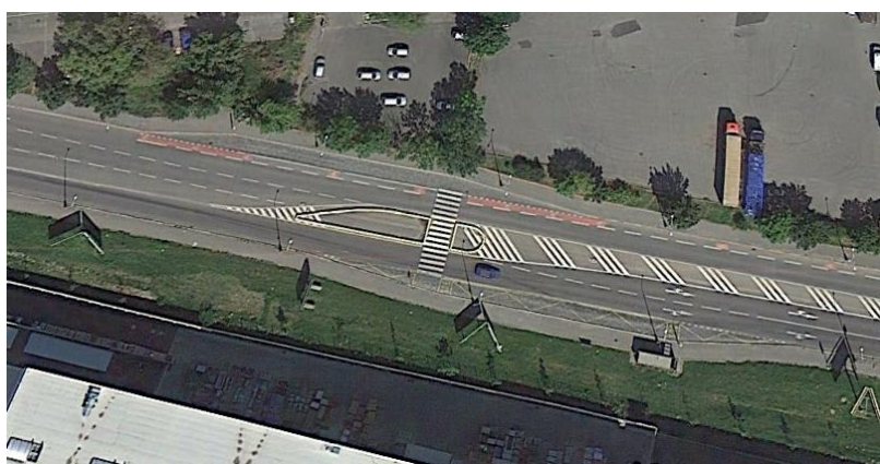
Obr. 6: Pohled na zastávku Bohdalecká (zdroj: Google Earth Pro)
