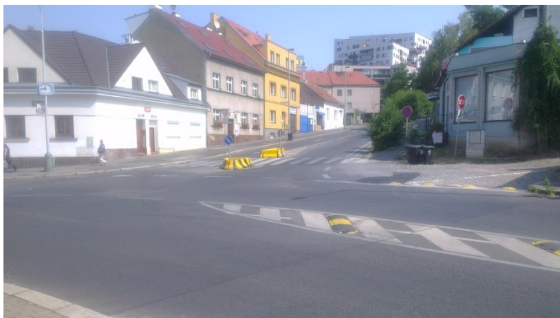
Obr. 41: Přechod pro chodce v ulici V Korytech (zdroj: David Petr)
