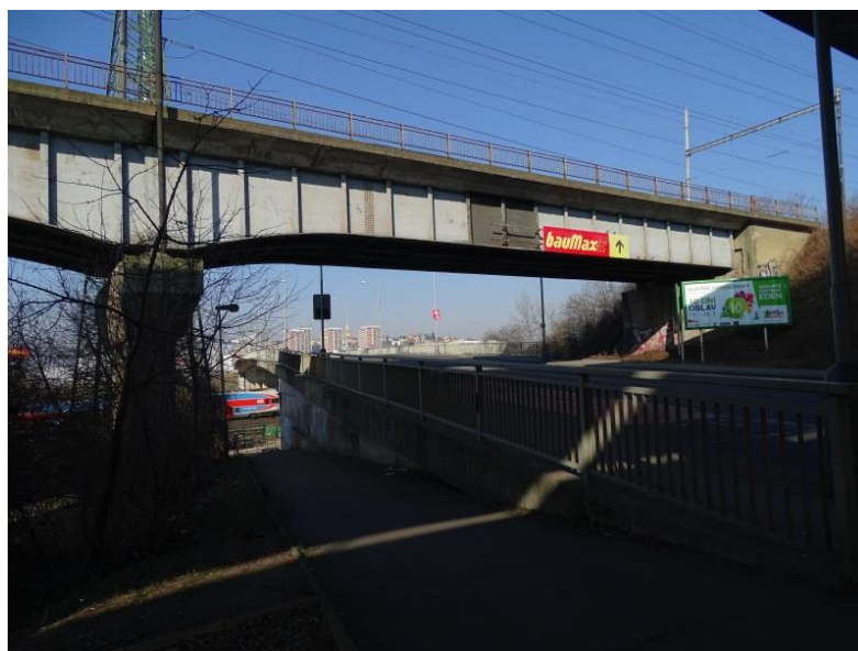
Obr. 5: Pohled na železniční most přes Záběhlickou. V pozadí je vidět přemostění odstavného nádraží Praha-Jih (zdroj: commons.wikipedia.org)
