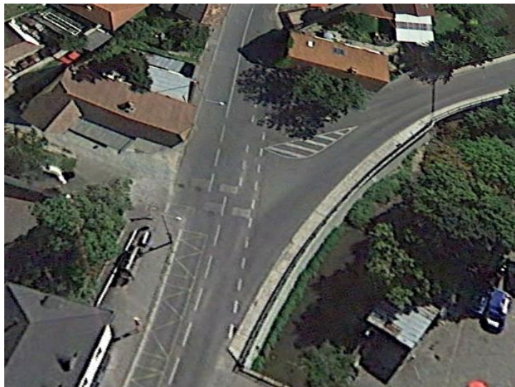
Obr. 36: Pohled na křižovatku Záběhlická/U Záběhlického zámku (zdroj: Google Earth Pro)
