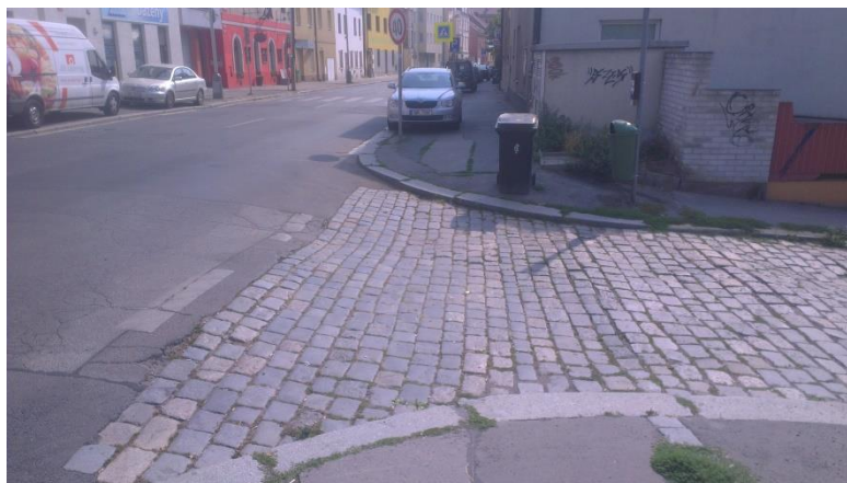
Obr. 69: Chybějící přechod a prvky pro NaS a OsSSP u křiž. s ulicí Na Lávce (zdroj: David Petr)
