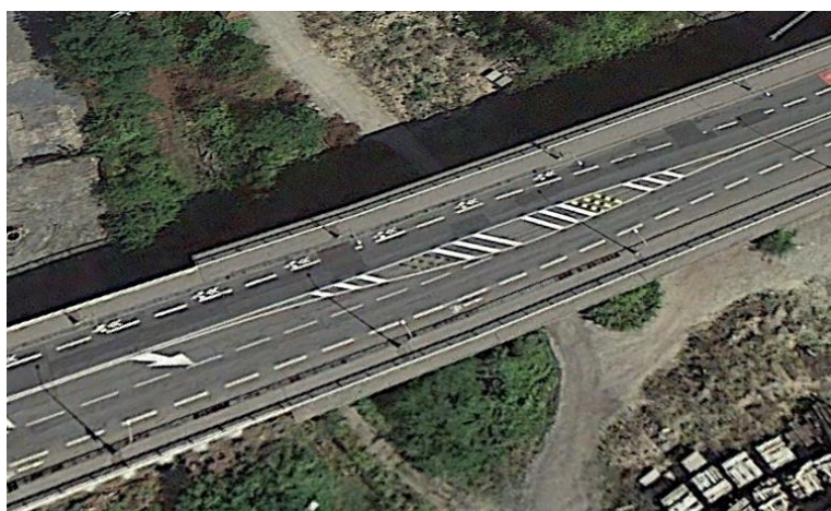
Obr. 28: Situace svedení do jednoho jízdního pruhu na mostě (zdroj: Google Earth Pro)
