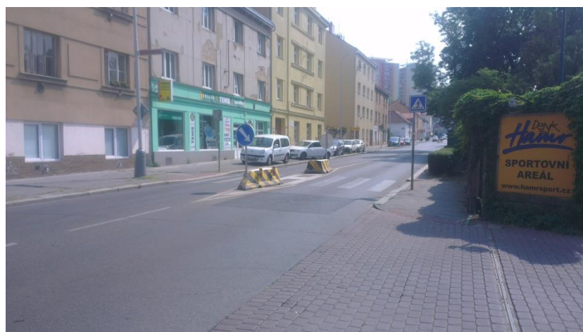
Obr. 32: Zklidňující prvek vytvořený z betonových bloků s SDZ C 4a (zdroj: David Petr)
