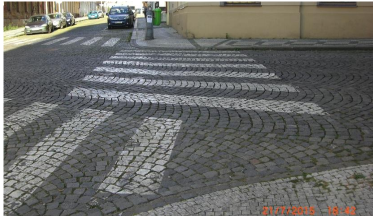
Obrázek 7 - Nesprávně navržený přechod v ulicích Vlkova, Krásova, Praha 3, zdroj: autor
