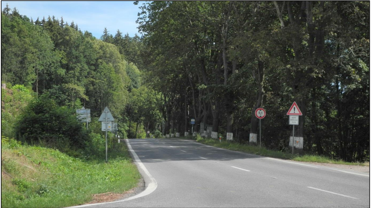
Obrázek 12: Nedostatečná vzdálenost mezi svislými dopravními značkami, pohled od stykové křižovatky se silnicí III/01412.
