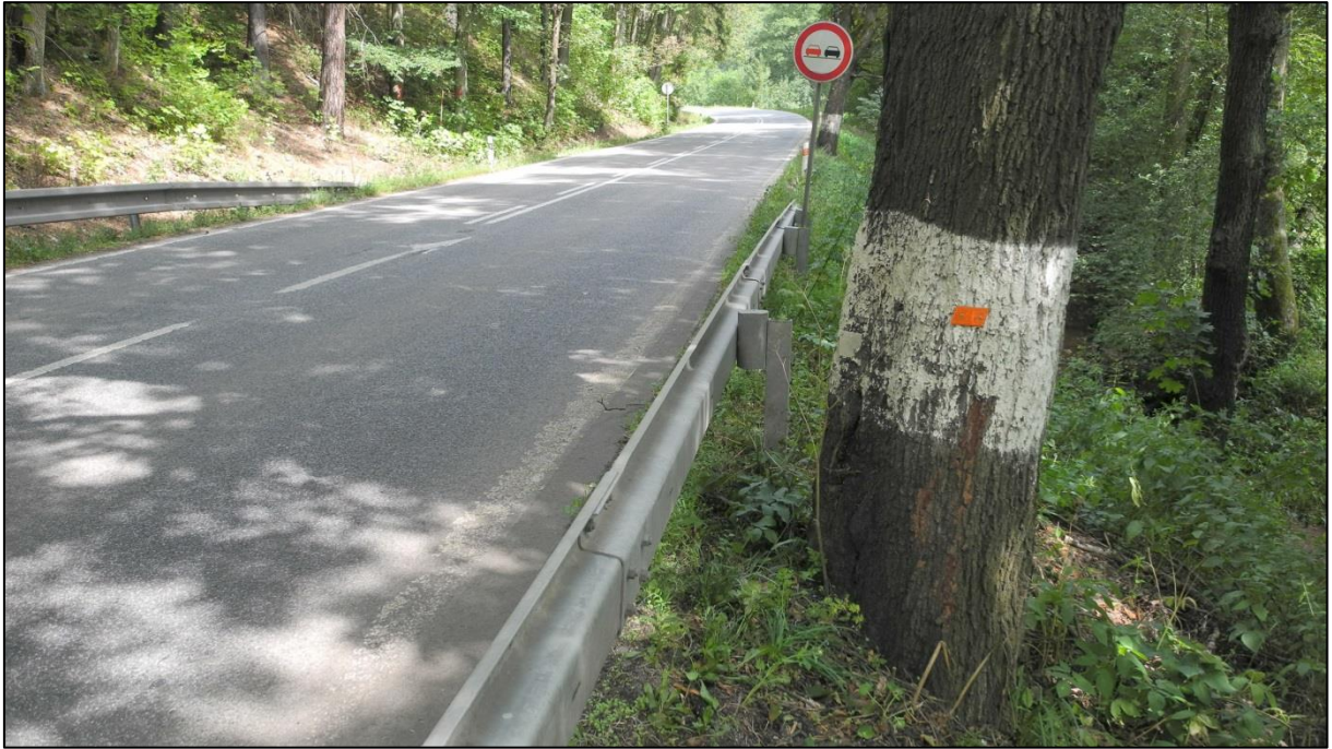
Obrázek 15: Strom, který nesplňuje minimální vzdálenost pevné překážky od líce svodidla.
