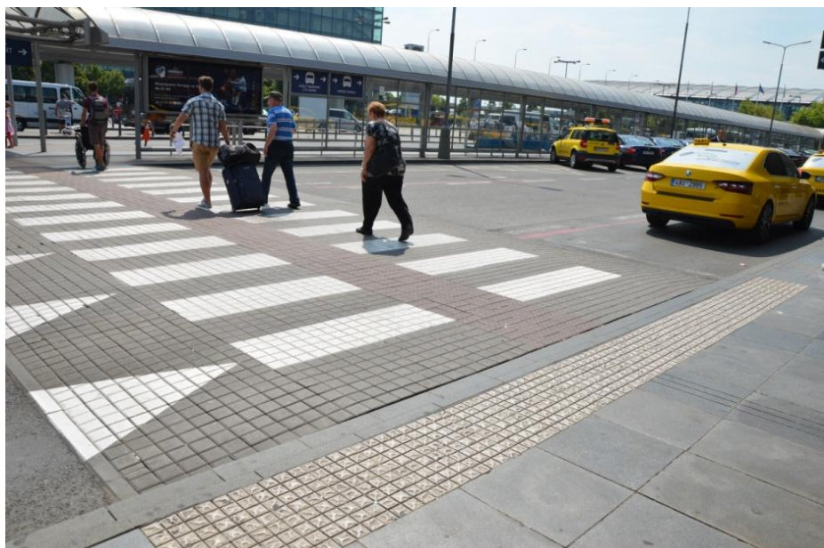
Obrázek 5 - úrovnňový přechod pro chodce, signální pás a vodící pás přechodu zdroj: fotoarchiv autorky
