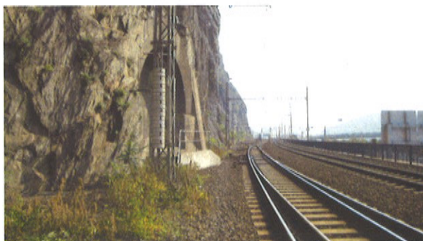
Obr. č. 15: Portál krytu civilní obrany, zdroj (vlastní)
