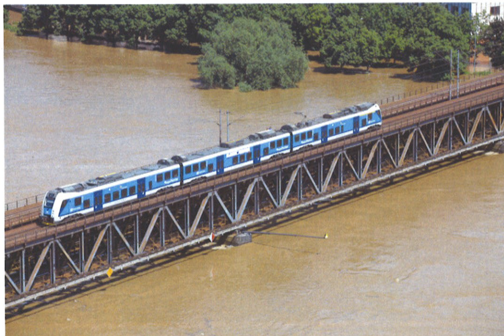
Obr. č. 26: Fotografie současného železničního mostu při povodni roku 2002, zdroj [61]
