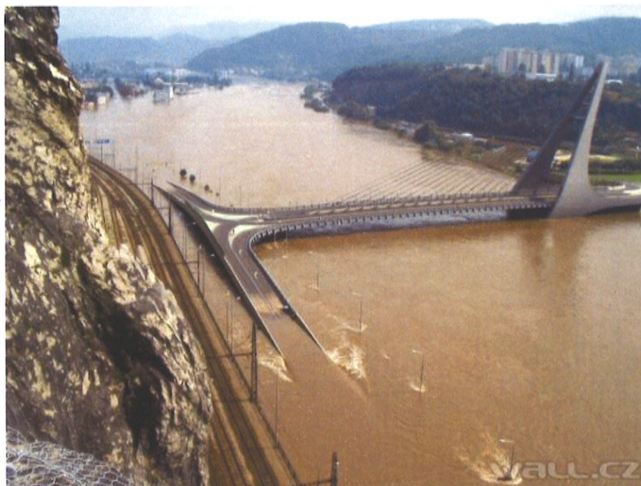
Obr. č. 20: Fotografie Mariánského mostu při povodni roku 2013, zdroj [64]
