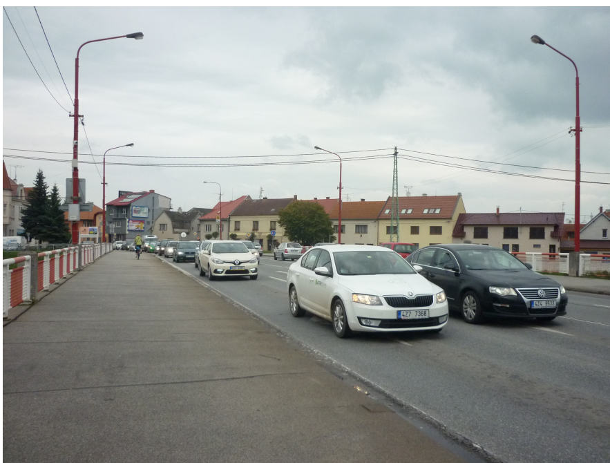
Obrázek 46: Křižovatka K100 při směrem z Uherského Hradiště do Starého města
