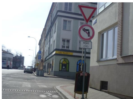
Obrázek 25 – Chybně použitá dodatková tabulka
