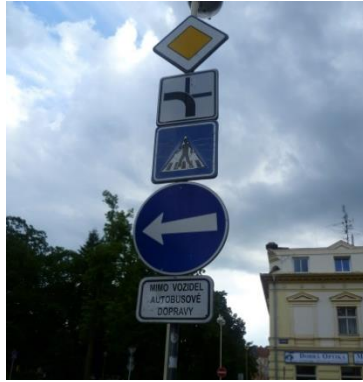
Obrázek 26 - Chybné společné umístění SDZ
