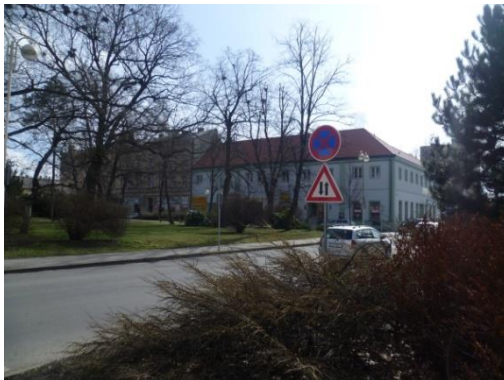
Obrázek 27 - Chybné společné umístění SDZ
