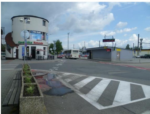
Fotografie 9 - Nerovnost na vozovce
