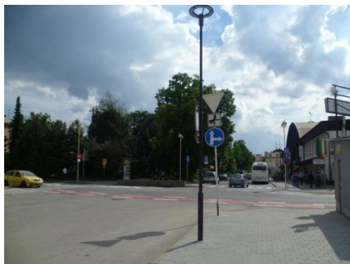
Obrázek 19 - Pohled na opotřebenou SDZ
