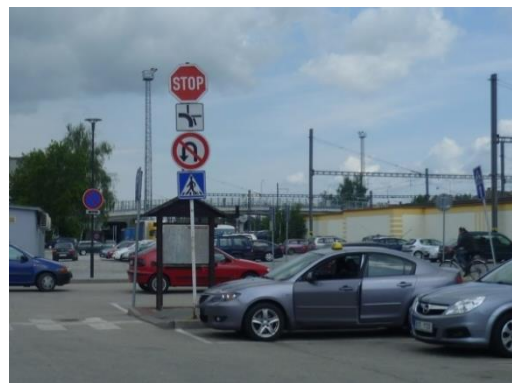
Obrázek 16 - Chybné společné umístění SDZ
