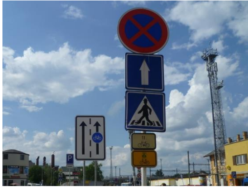
Obrázek 17 - Chybné společné umístění SDZ
