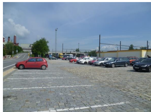
Fotografie 12 - Parkovací plocha vedle výpravní budovy železniční stanice
