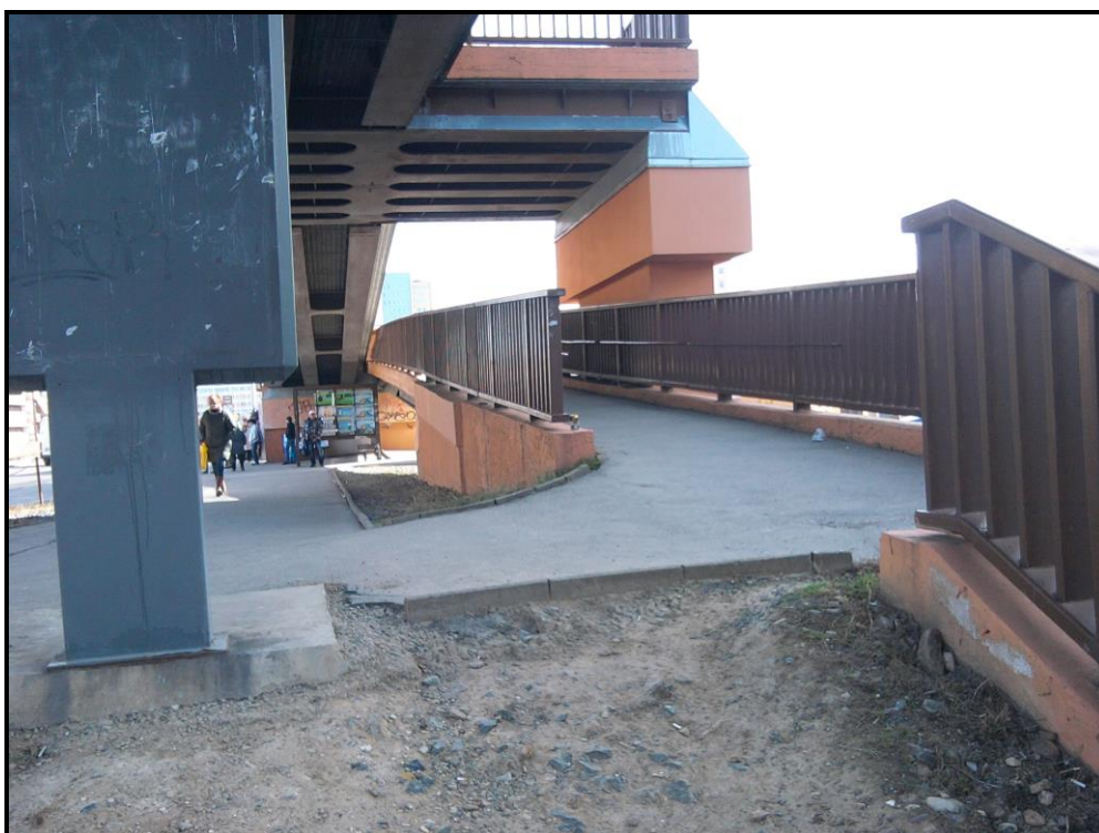
Obrázek 2: Rampa u zastávky v ulici Opatovská
