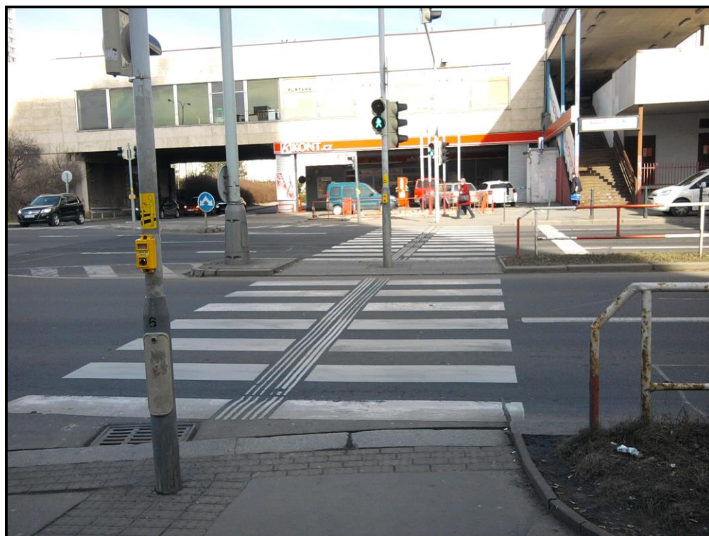
Obrázek 4: Přechod pro chodce v rámci uzlu Háje
