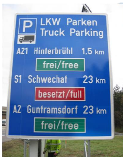
Obrázek 12: Proměnné dopravní značení zobrazující informaci o obsazenosti parkoviště v Rakousku. Zdroj: [29]
