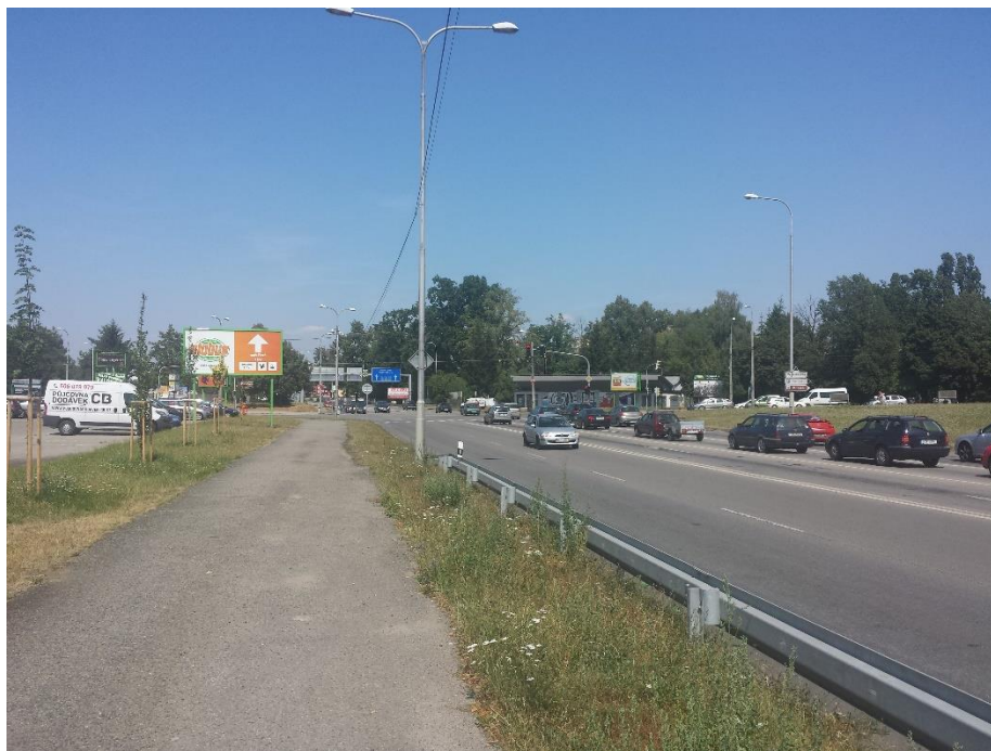
Pohled na čtyřramennou křižovatku ulice Na Dlouhé louce jih, směr od OD Kaufland
