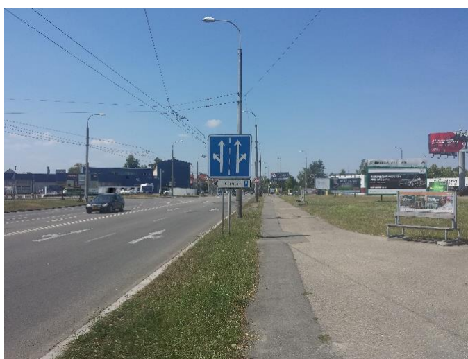
Chybějící prvky pro nevidomé a slabozraké na chodníku, reklamy pohled do ulice Husova tř. západ
