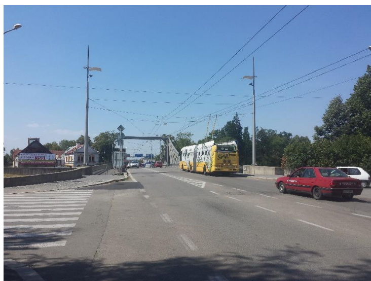
Pohled na Dlouhý most směrem od centra
