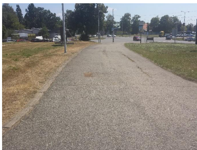
Chybějící prvky pro nevidomé a slabozraké na chodníku pohled od ulice Husova tř. západ
