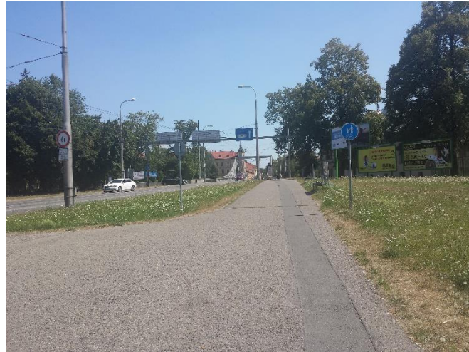
Pohled na Dlouhý most směr centrum od čtyřramenné křižovatky, chybějící prvky pro nevidomé a slabozraké
