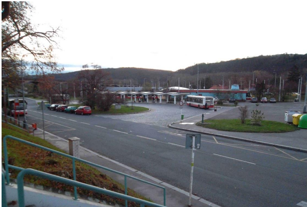
Obrázek 10.8 : Vjezd do autobusového obratiště z komunikace Pikovická se nalézá jihozápadně od hlavního přístupového schodiště k nástupištím ŽST. Z fotografie je patrný nepříznivý sklon hrany obrubníku u vjezdu do autobusového obratiště. Současně je také patrná poloha výstupní zastávky.
