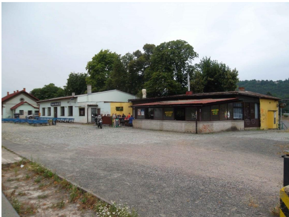
Obrázek 10.18 : Po příchodu po hlavním přístupovém k schodišti na plochu ŽST mineme objekt s restauračním zařízením. Vlevo od něj je umístěna čekárna, v níž je umístěna i prodejna jízdenek. Zcela vlevo je umístěna výpravní budova.
