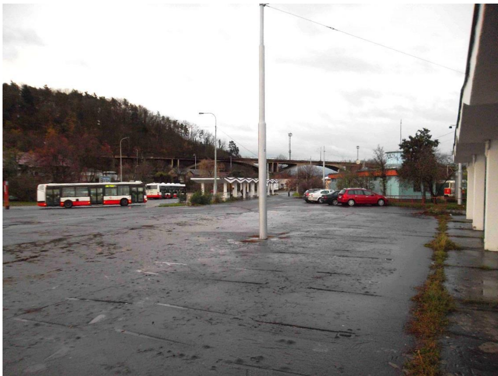
Obrázek 10.24 : Pohled od přístřešku tramvajové zastávky směrem k autobusovému obratišti. Zcela vlevo se nalézá označnický výstupní zastávky autobusů, vpravo budova se sociálním zařízením.
