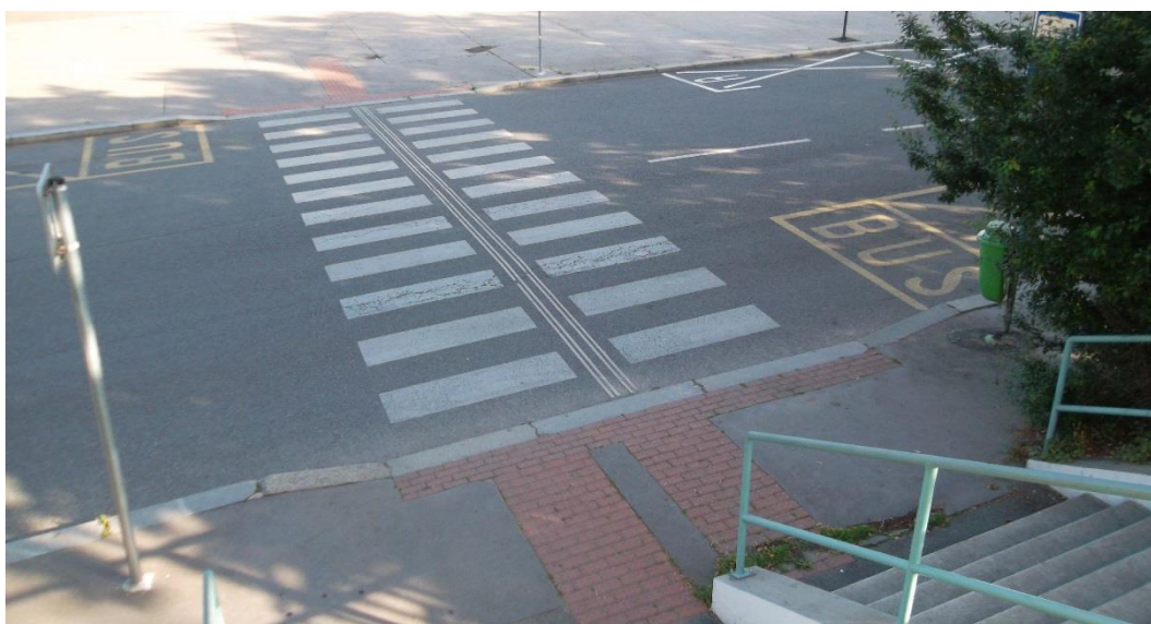
Obrázek 10 : Úpravy pro osoby se zrakovým postižením na přechodě pro chodce u hlavního přístupového schodiště k nástupištím ŽST (zdroj: autor, 2015)
