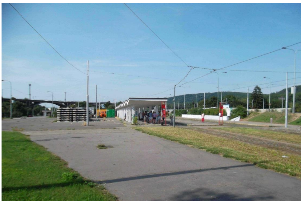
Obrázek 10.16 : K nástupu cestujících do tramvajových vozů slouží dvě nástupiště. Původně byla čekárna umístěna i na ploše nástupiště vnitřní koleje. Vlevo je vidět část pochozí plochy, která vznikla po zrušení části autobusového nádraží.
