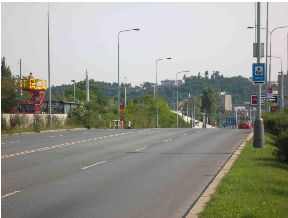
Obrázek 10.1 : Pohled na komunikaci Modřanská v úrovni přednádražního prostoru. Vlevo jsou vidět nácestné tramvajové zastávky trati do Modřan a nácestná autobusová zastávka umístěná v jízdním pruhu komunikace. Výškový oblouk komunikace je přítomen z důvodu podchodu, který je umístěn pod touto komunikací.
