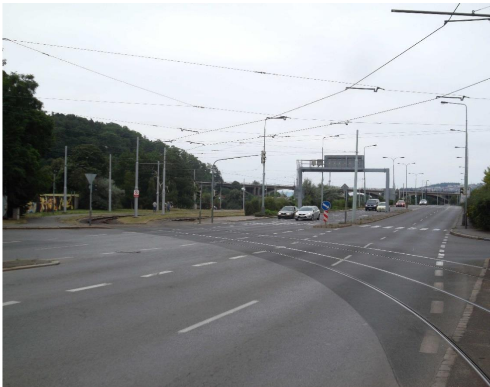
Obrázek 10.12 : Křižovatka komunikací Modřanská × Údolní × U Kempinku (pohled směrem z centra). Tramvajová trať zde křižuje místní komunikaci Modřanská, čímž je zajištěno její směrové vedení do prostoru uzlu.
