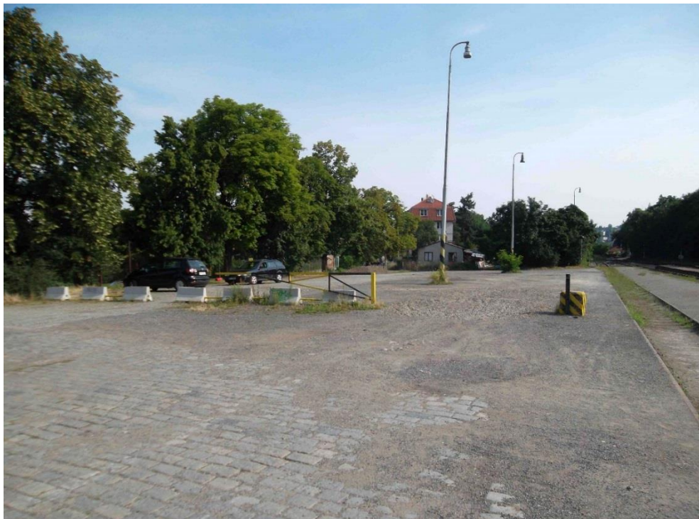
Obrázek 10.20 : Volná skládka je součástí malého nákladového obvodu, který je umístěn severovýchodně od výpravní budovy. V současnosti je využití nákladového obvodu minimální.
