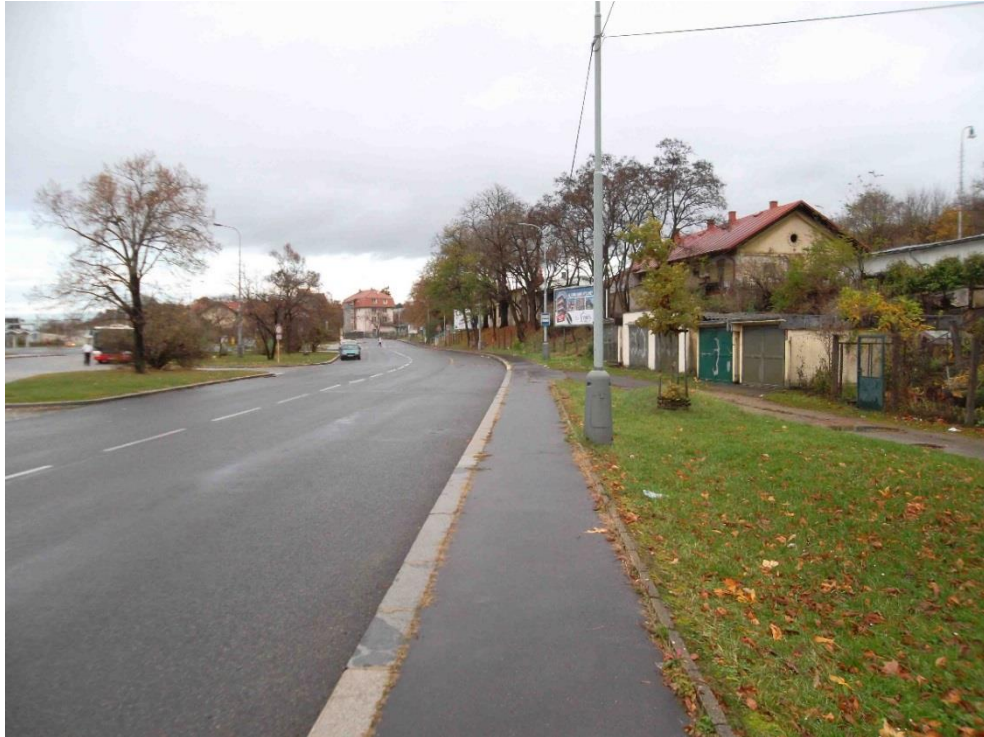
Obrázek 10.5 : V místech budov ŽST je komunikace Pikovická vedena v přímé, na jejím konci následuje pravý směrový oblouk. Vlevo je umístěno autobusové obratiště, vpravo lze vidět parkovací garáže. Pohled směr křižovatka s komunikací Údolní.
