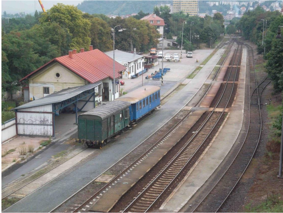
Obrázek 10.21 : Celkový pohled na ŽST v prostoru nástupišť. Na fotografii je patrné i umístění dvou vlečkových kolejí.
