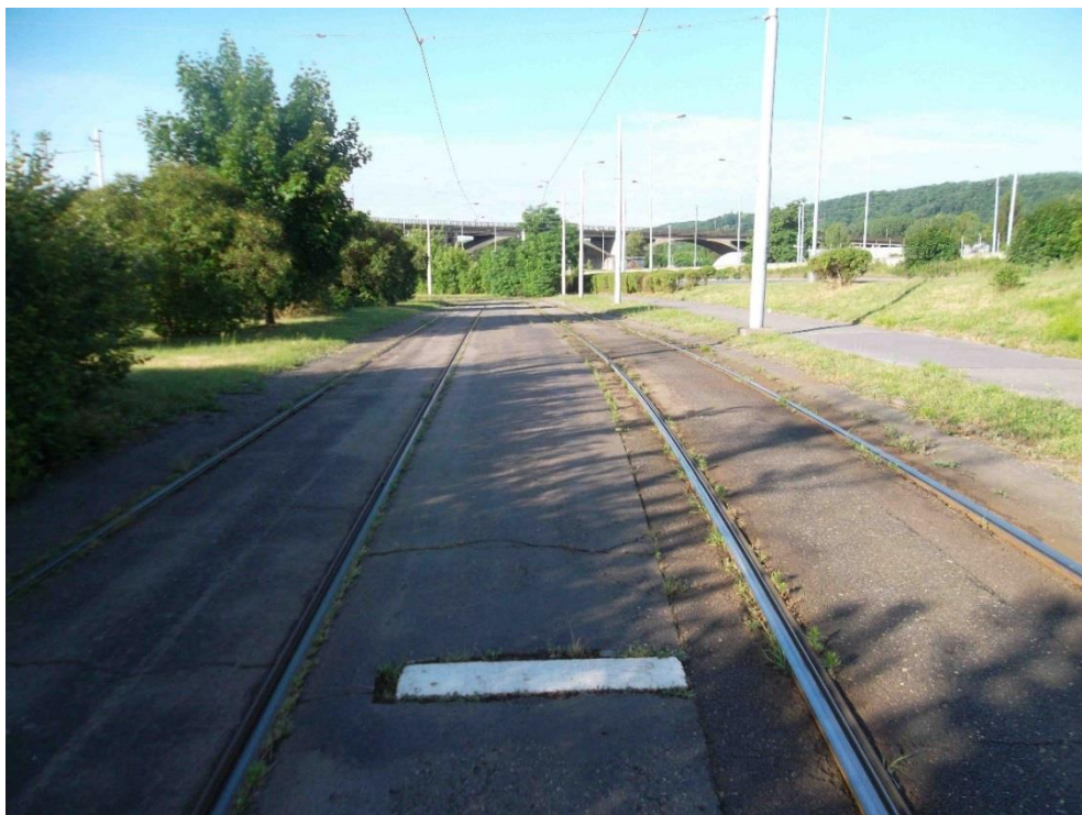
Obrázek 10.14 : Zpočátku je obratiště tvořeno dvěma kolejemi. Na konci úseku kolejí v mezipřímé je ve vnější koleji umístěna rozjezdová výměna a směrové oblouky. Za rozjezdovou výměnou je obratiště tvořeno třemi kolejemi. V pravé části fotografie je patrný pás pro chodce sloužící k přístupu na pochozí plochu Branického mostu.
