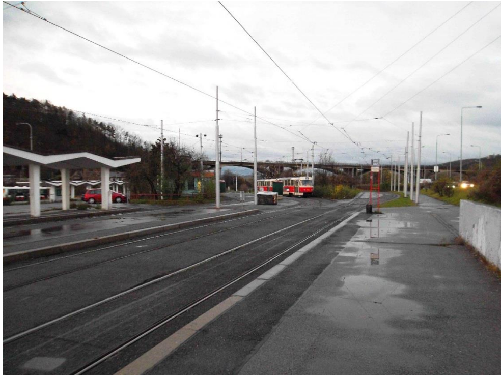
Obrázek 10.13: Výstupiště výstupní zastávky tramvají je pro dva vlaky vozů 2x T3. Na jeho začátku je umístěno schodiště a šikmá rampa pro přístup do podchodu pod komunikací Modřanská. Tramvajové obratiště je tvaru smyčka.
