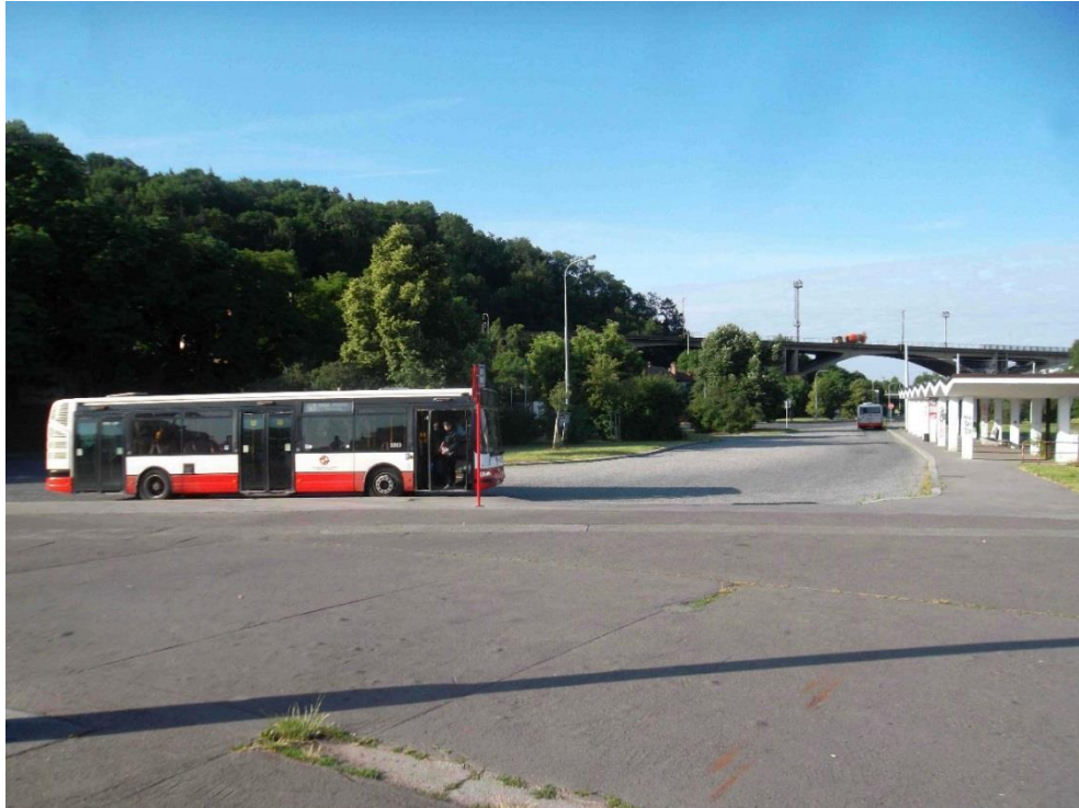
Obrázek 10.9 : Pohled na celkové uspořádání autobusového obratiště. Vpravo je vidět přístřešek nástupní zastávky. V levé části obratiště je možný odstav autobusů.
