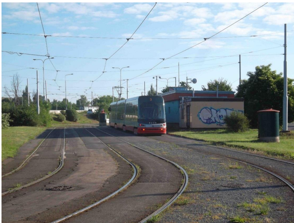
Obrázek 10.15 : Pohled na mezipřímé tramvajového obratiště u objektu tramvajového obratiště
