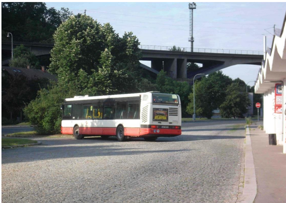
Obrázek 10.10 : K výjezdu z autobusového obratiště slouží samostatný sjezd mezi dvěma zelenými ostrovy. Zcela vpravo je umístěn označnick nástupní zastávky. Za označnickem slouží obratiště podél obou zvýšených obrub pro odstav vozidel.
