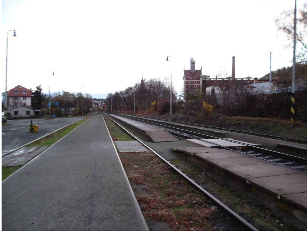
Obrázek 10.19 : Pohled na část kolejí ŽST směrem ke krčskému zhlaví. Příchod cestujících na nástupiště je úrovnňový.
