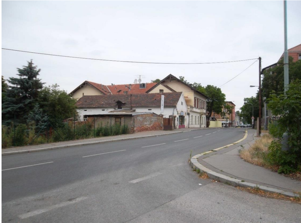
Obrázek 10.3 : Samostatný sjezd z volné skládky ŽST do komunikace Pikovická. V návrzích uskutečňují demolici části budov na snímku. Pohled směr křižovatka s komunikací Údolní.
