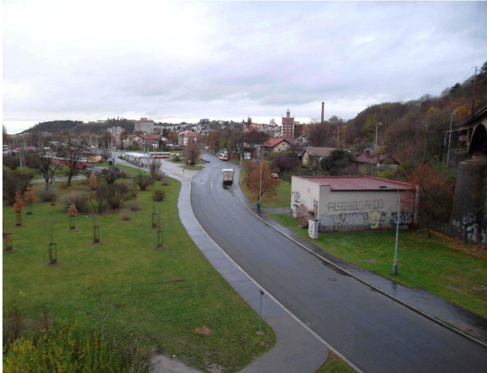
Obrázek 10.7 : Celkový pohled na komunikaci Pikovická v přednádražním prostoru. Fotografie zobrazuje dispoziční řešení přednádražního prostoru (polohu ŽST, autobusového a tramvajového obratiště).
