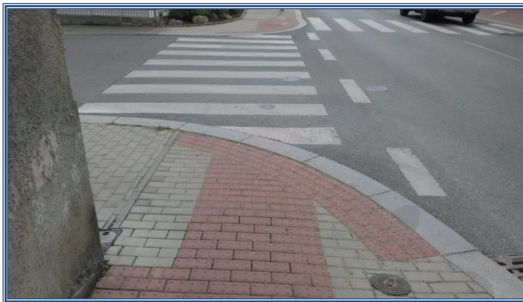
Obr. 22: Nesprávné provedení varovného pásu
