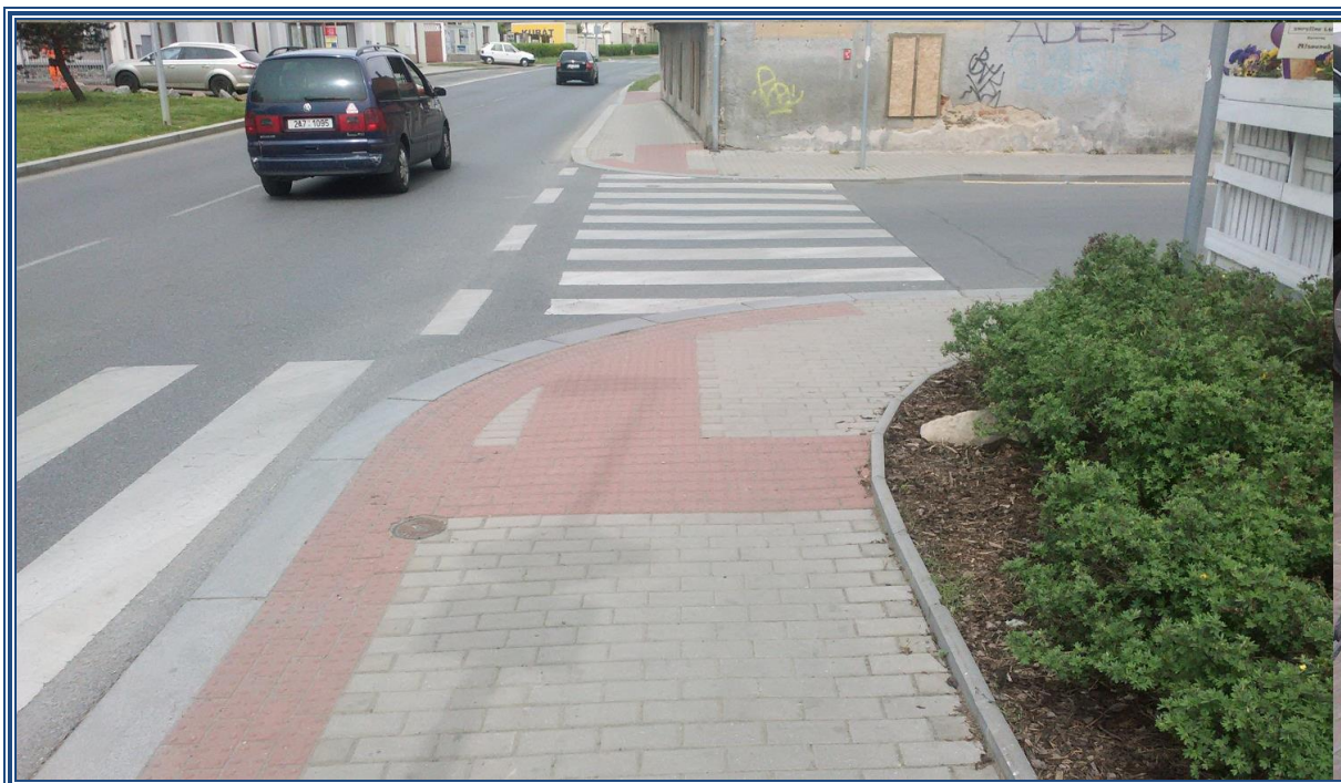
Obr. 24: Nesprávné spojení signálních pásů
