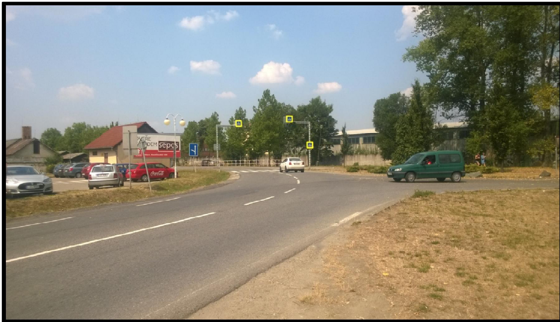
Obrázek 10 - Pohled na zvýrazněný přechod pro chodce na ulici Rantířovská (severní rameno), v popředí odbočka doprava na ČS ONO, v pozadí odbočka vlevo k supermarketu COOP
