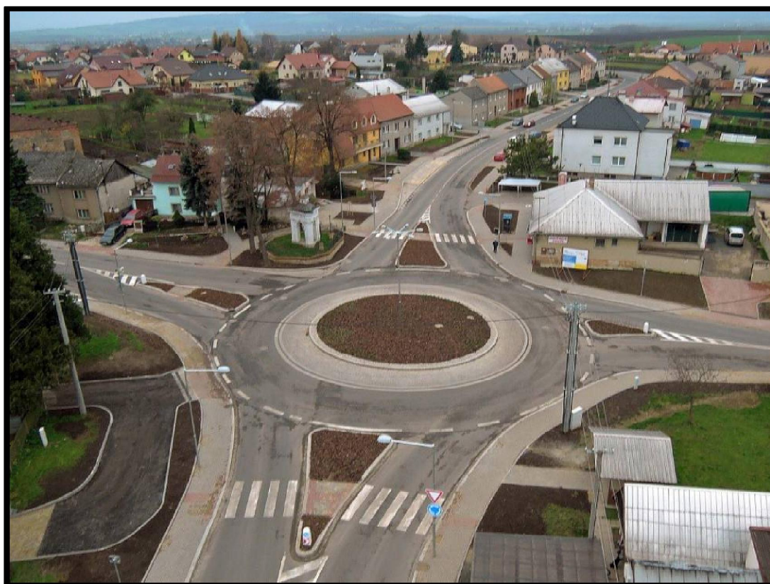
Obrázek 30 - Příklad OK z Hněvotína, kde je možné vidět středový pojezděný prstenec a střední dělicí ostrůvek s přechodem pro chodce i s místem pro přecházení [010]
