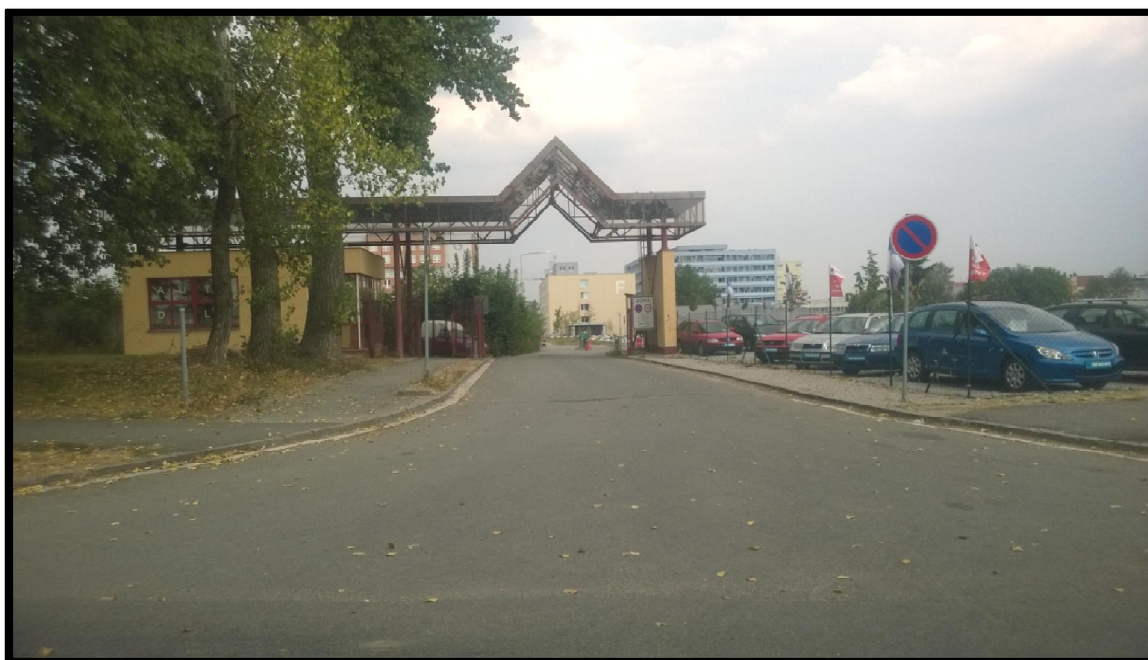
Obrázek 14 - Pohled na zadní vjezd do areálu nemocnice
