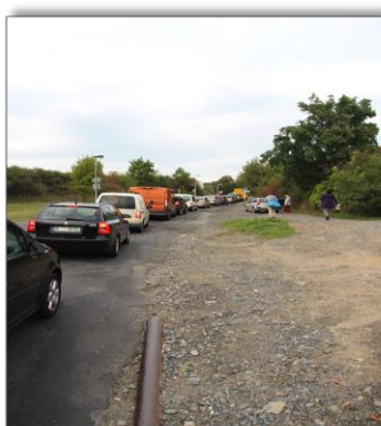
Obrázek 43: Hartenberská ulice – chybějící krajnice [27]
