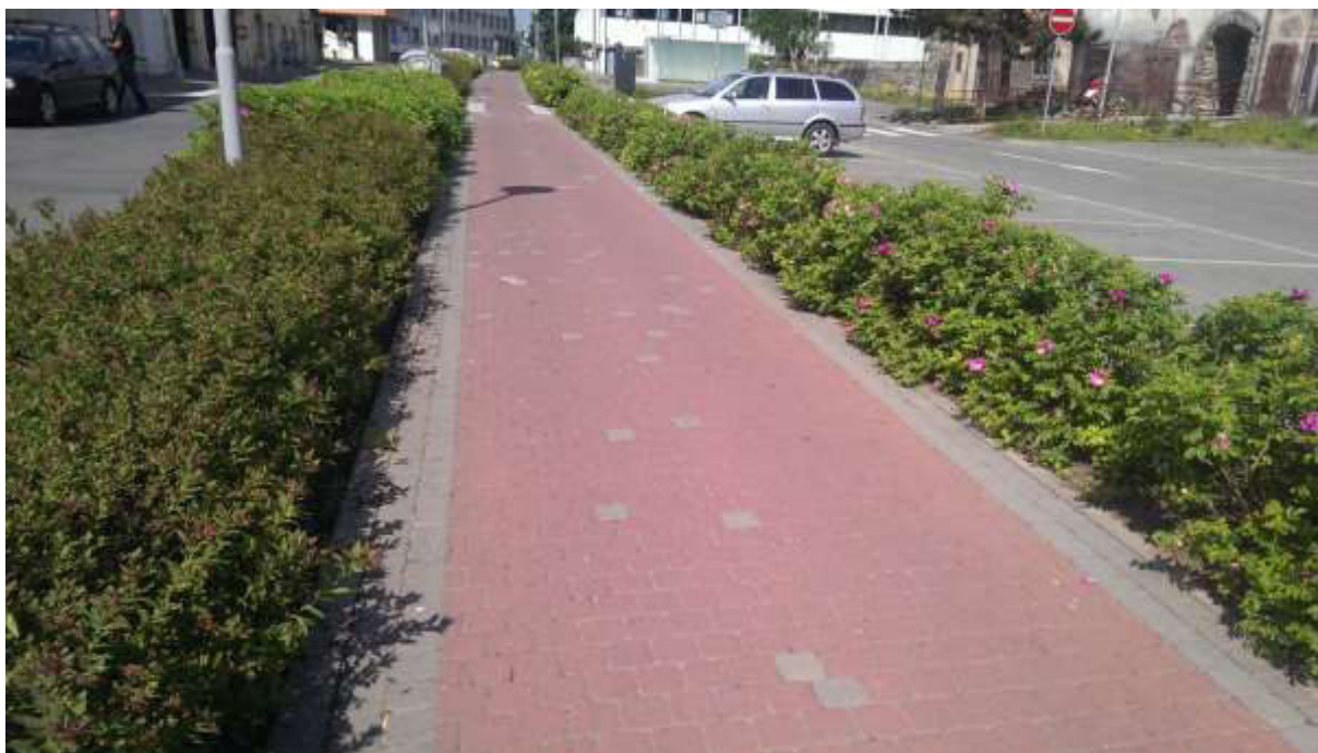
Obrázek 12: Příklad nesprávného užití barevně rozlišené dlažby
