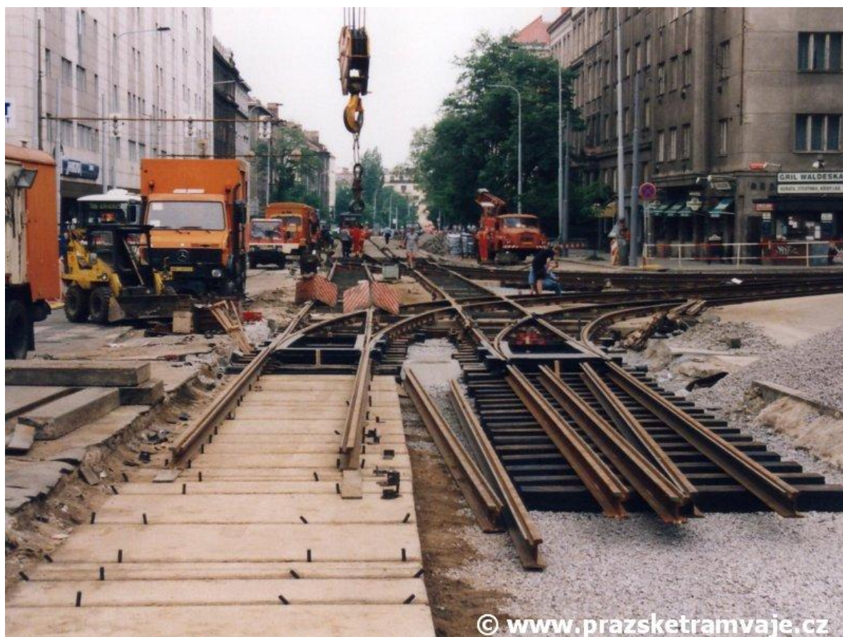
Obrázek č. 8. Panely VÚIS na křižovatce Koh-i-noor při rekonstrukci v roce 2002. [9]
