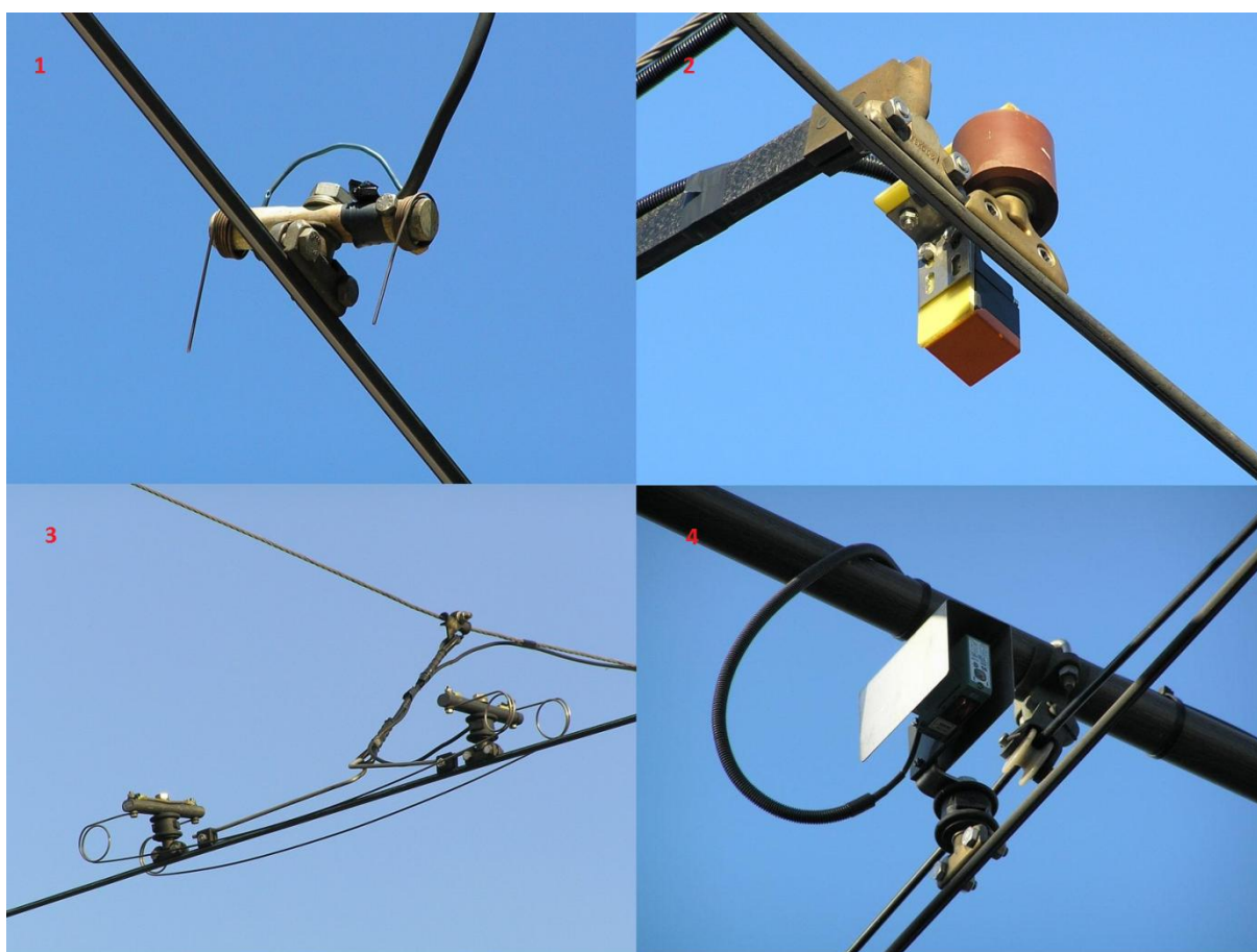
Obrázek č. 12. 1) pružinový trolejový detektor, 2) Indukční čidlo, 3) Dvojitá podélná pružina, 4) STOD 1 [18]
