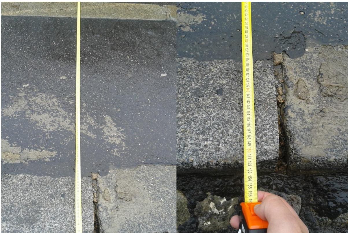
Obrázek č. 18 Nedostatečná šířka nástupního ostrůvku v nástupní zastávce Kubánské náměstí (foto autor duben 2015)
