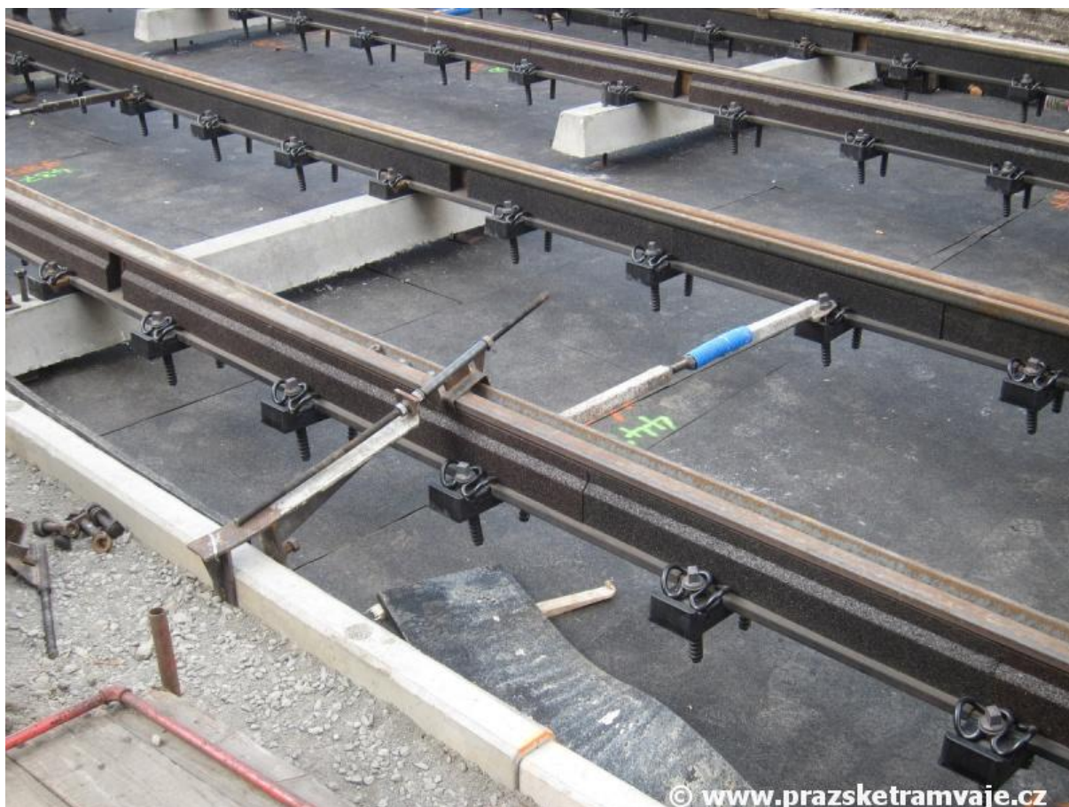
Obrázek č. 6 Konstrukce trati metodou W-tram [6]
