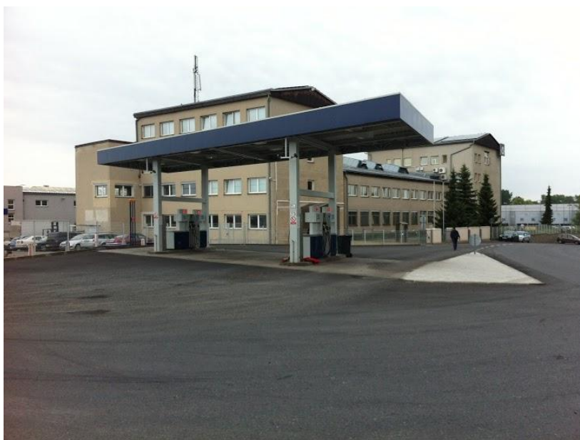
Obr. č. 4 čerpací stanice v areálu firmy
