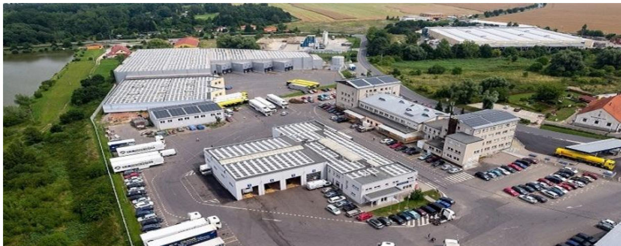
Obr. č. 2 Sídlo společnosti v Chýni
