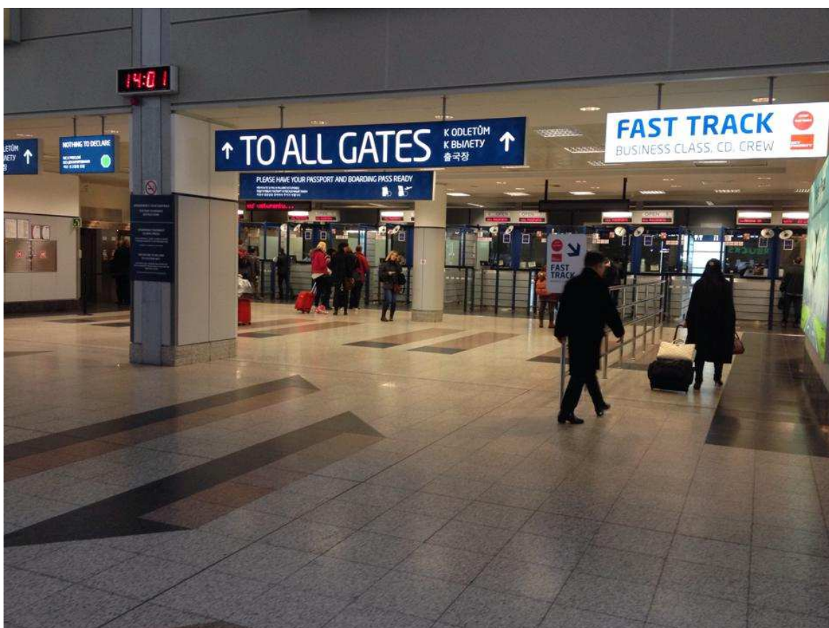
Obrázek 16: Přístup k pasové kontrole, Terminál 1
