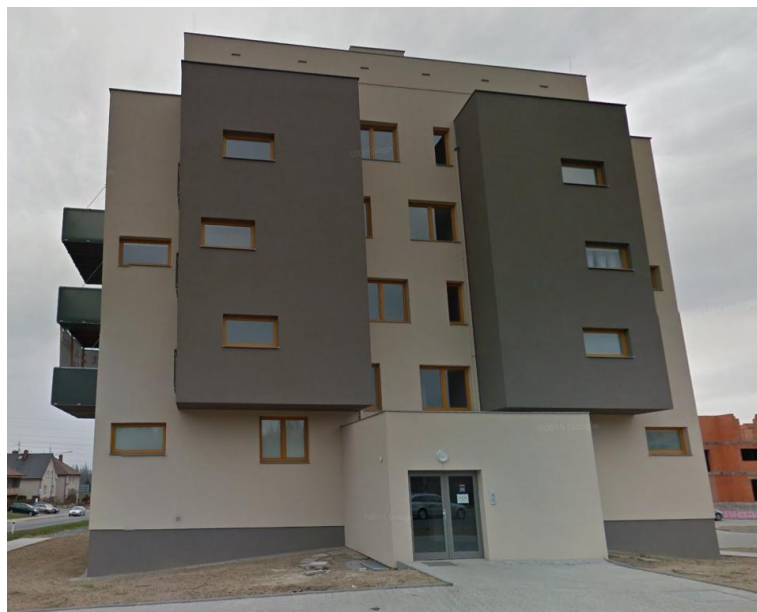
Obr. 4.4 - Pohled z ulice
