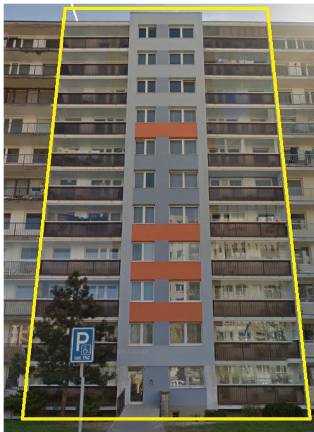
Obr. 4.9 - Pohled z ulice
