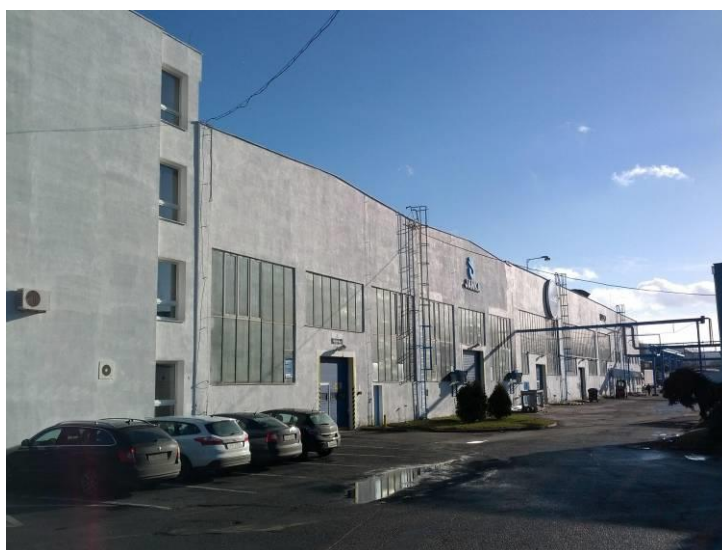
Obrázek 1.1- Výrobní prostory firmy JANKA ENGINEERING s r.o. a LLOYD coils
