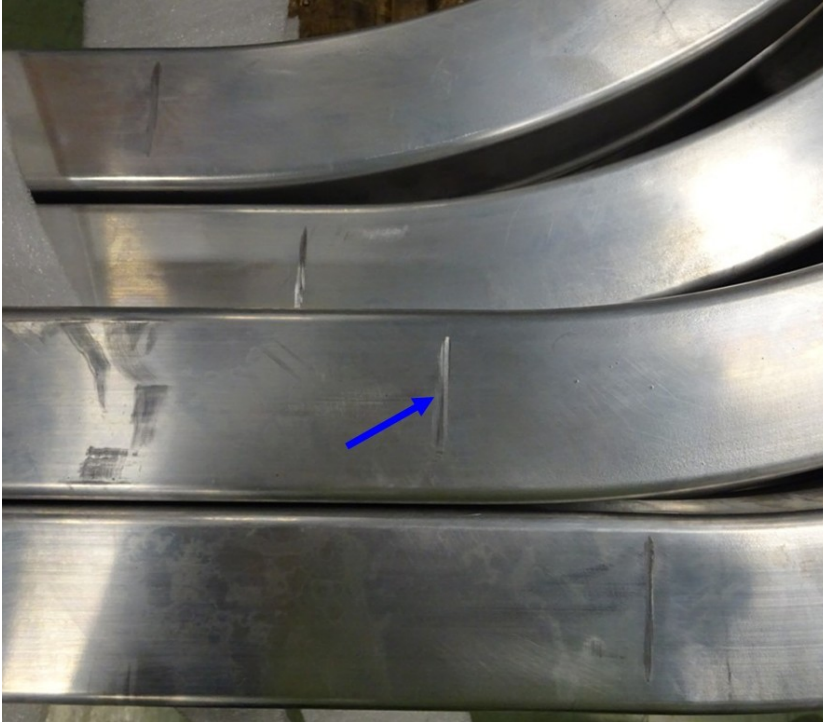
Obrázek 4.4-04: Vada B - otlaky na horní ploše kratší části
