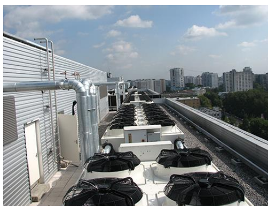
Obr. 4–3 Umístění suchých chladičů na střeše budovy [30]
