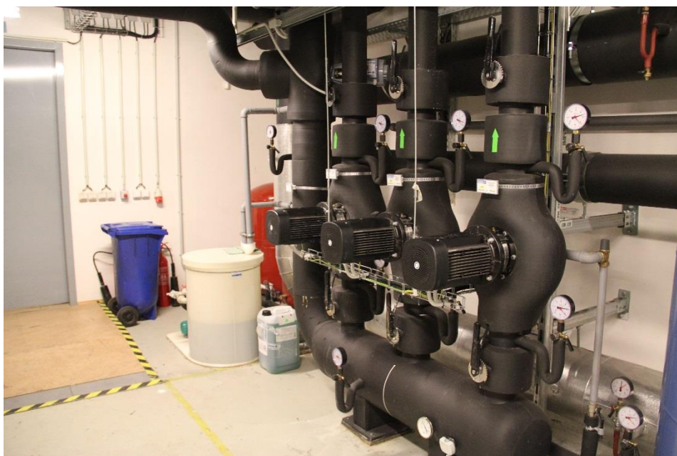
Obr. 4–2 Čerpadlová skupina chladícího okruhu
