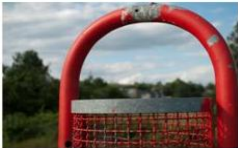
Obr.7: Ztráta přilnavosti nátěrového systému na Zinkovém povlaku
