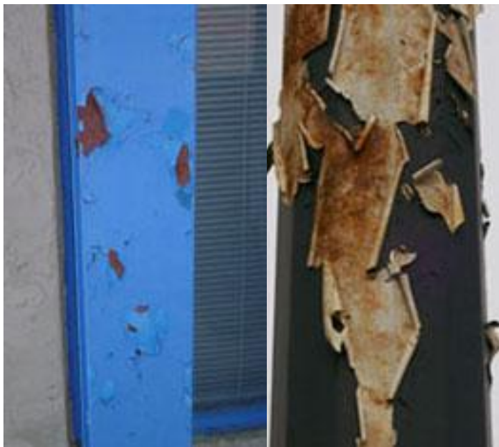
Obr.3: Odlupování nátěrového systém [14]
