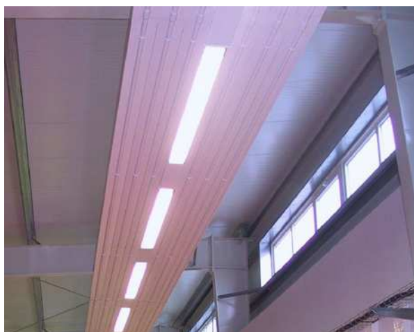
Obr. 11 Vodní sálavý panel s integrovaným osvětlením [19]
