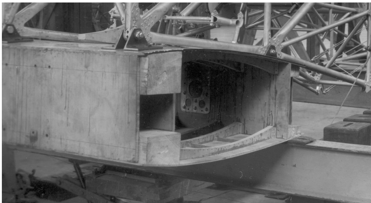
Obr. 4: Řez nosníky letounu Avia B-135 při pevnostní zkoušce trupu [20]
