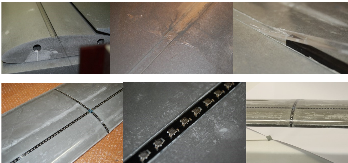
Obr. 5.11: Osazení křídla tlakovými pásky
