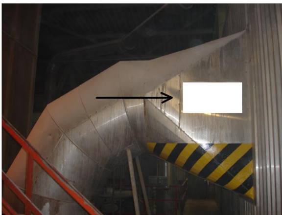
Obr. 10 Vstup znečištění do filtru sušícího okruhu
