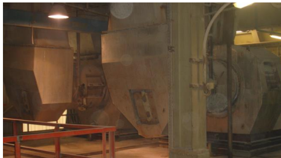
Obr. 9 Radiální ventilátory řešeného sušícího (vpravo) a chladícího (vlevo) okruhu které mají stejné parametry.
