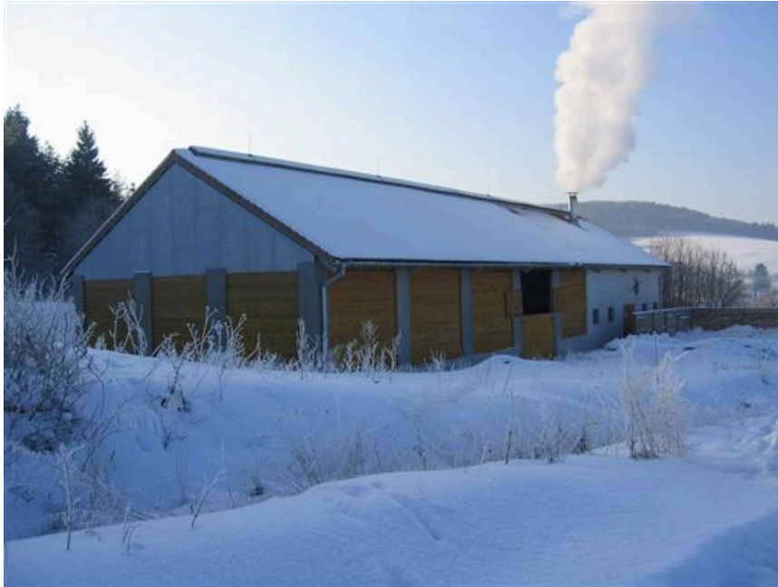
Obr. 2-23. Obecní výtopna na biomasu v Hostětíně [26]
