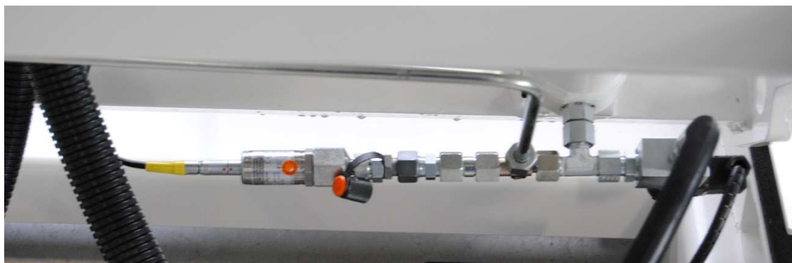
OBR. 6.3 PŘIPOJENÝ MĚŘÍCÍ BOD S TLAKOMĚREM
