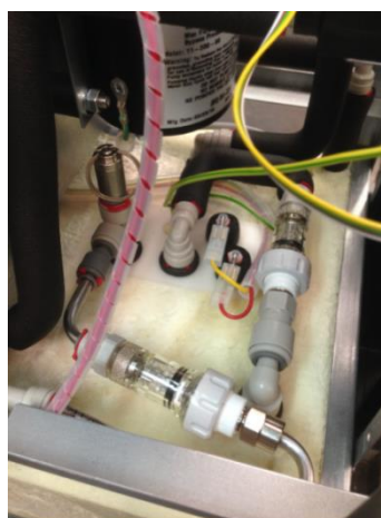
Obr. 15 – Trubky napojené na saturátor
