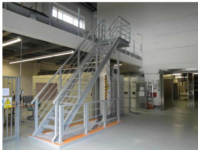
obr. 2: Průmyslové pomocné schodiště [3]
