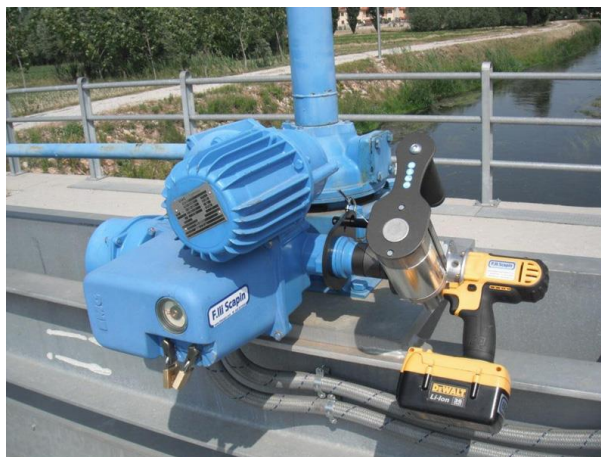
obr. 7.: Bateriový přenosný pohon na převodovce vřetenového zvedáku [8]
