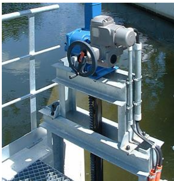
obr. 8.: Hřebenový zvedák stavidla s elektromotorem a čelní převodovkou [9]
