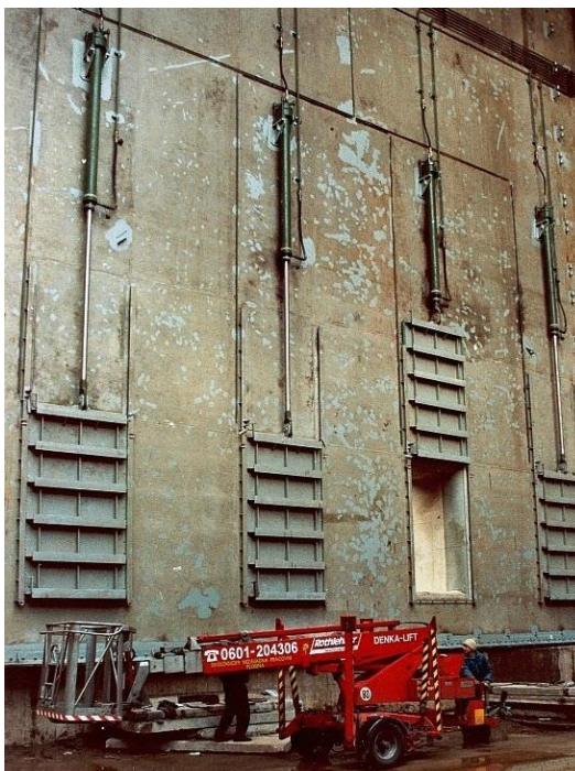
obr. 1.: Hydraulicky poháněná stavítka vodního díla Gabčíkovo [4]
