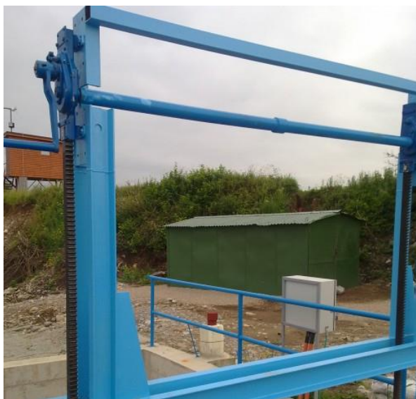
obr. 6.: Soustava hřebenových zvedáků s ručním pohonem [7]
