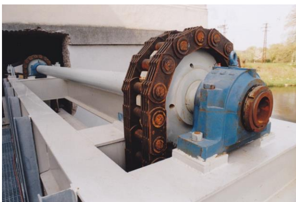
obr. 5.: Řetězový pohon stavidla vodní elektrárny Přelouč [4]
