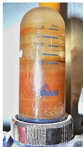
Obr. 8 Průhledka průtokoměru
