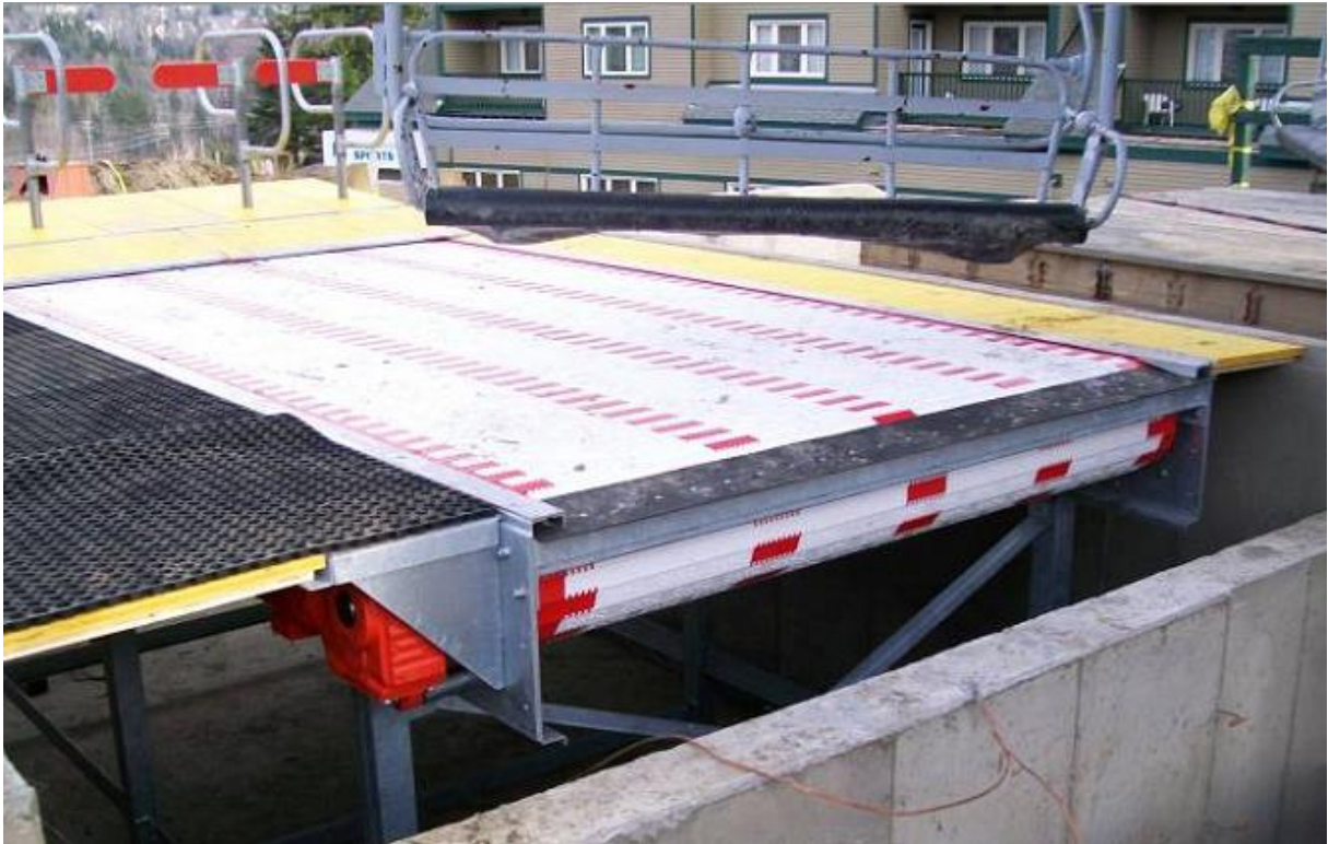
obr. 3: Hluboká betonová jáma pro odpojitelný typ lanovky [6]
