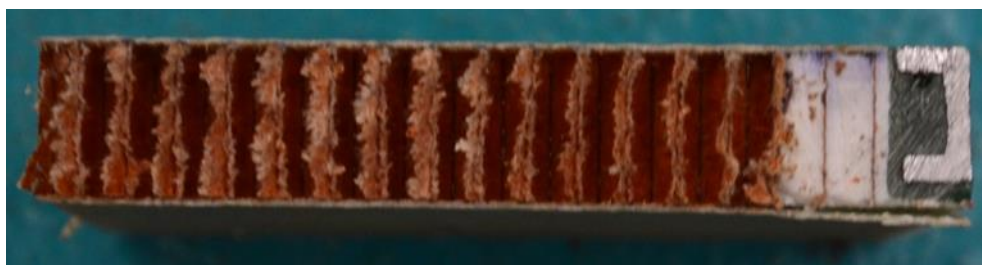
Obr. 5.10: Delaminace plniče od spodního potahu
