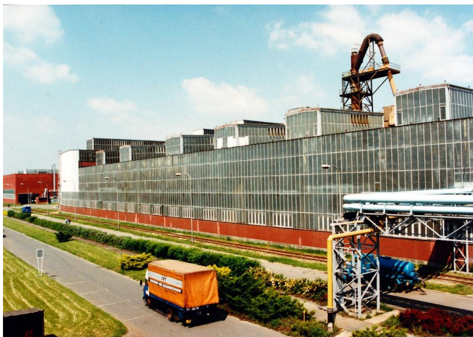
Obrázek 4: Výrobní budova společnosti ZPS-SLÉVÁRNA, a.s.
