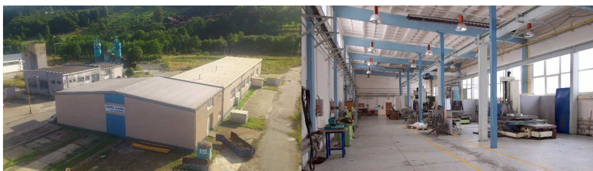
Obr. 2.1.3 Současná výrobní hala 2009-dnes
