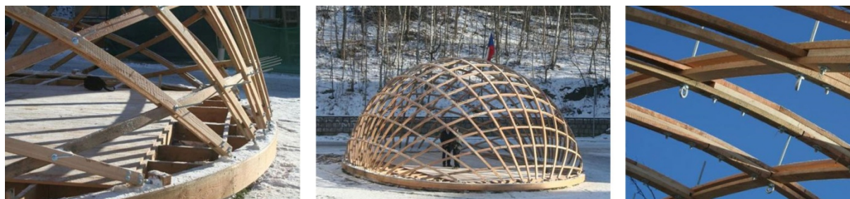
Obr.08) Apres Ski – exteriér, detail
