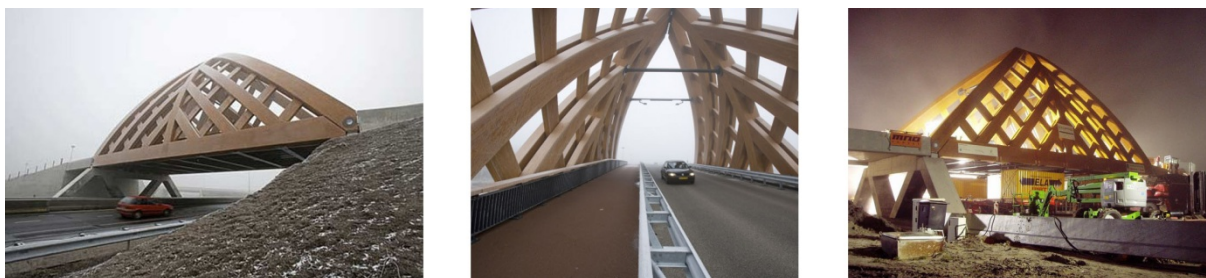
Obr.16) Dálniční most Krusrak –exteriér
