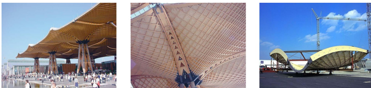
Obr.15) Expo-dach Hannover – exteriér, interiér a postup konstrukce
