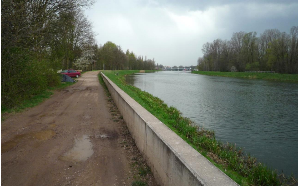
Obr. 26: Pardubice – stacionární protipovodňová stěna na levém břehu Labe u parku Na Špici. (Foto: Veronika Šindlerová, 2012)
