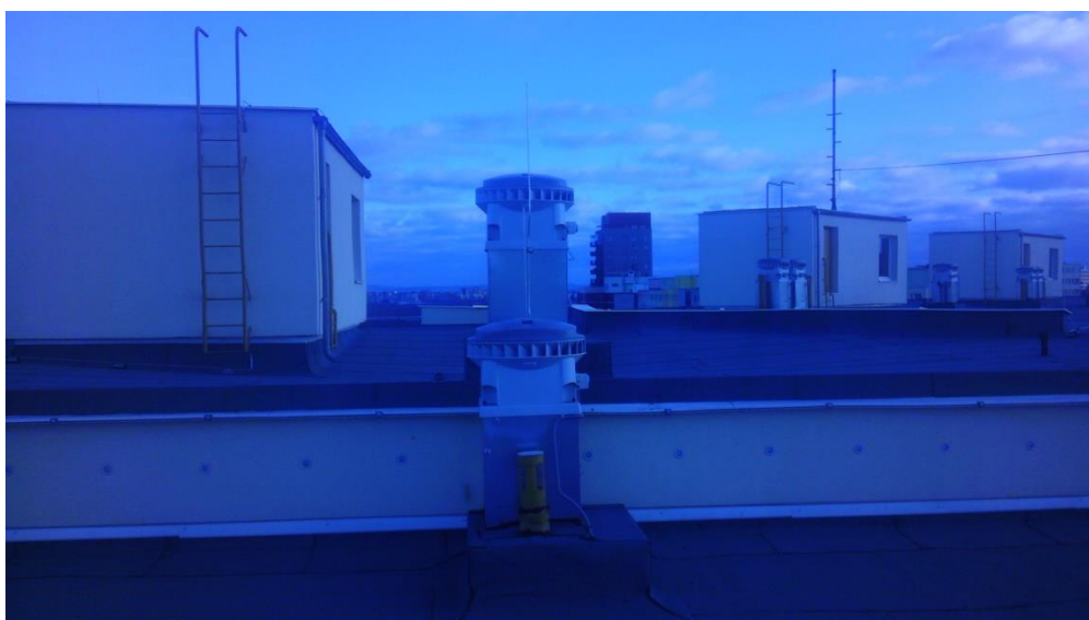
Obrázek 6: Bývala strojovna výtahu - vně
