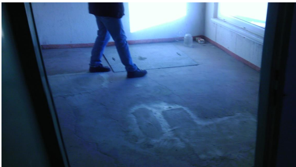
Obrázek 5: Bývalá strojovna výtahu - uvnitř
