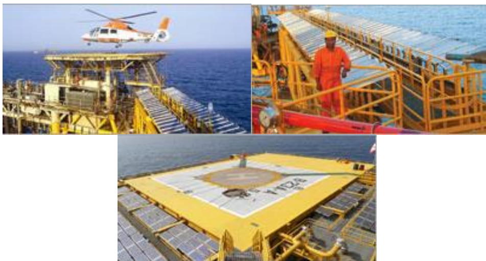
Obrázek 6 – Použití solární panely na těžebních vrtacích plošinách [21].
