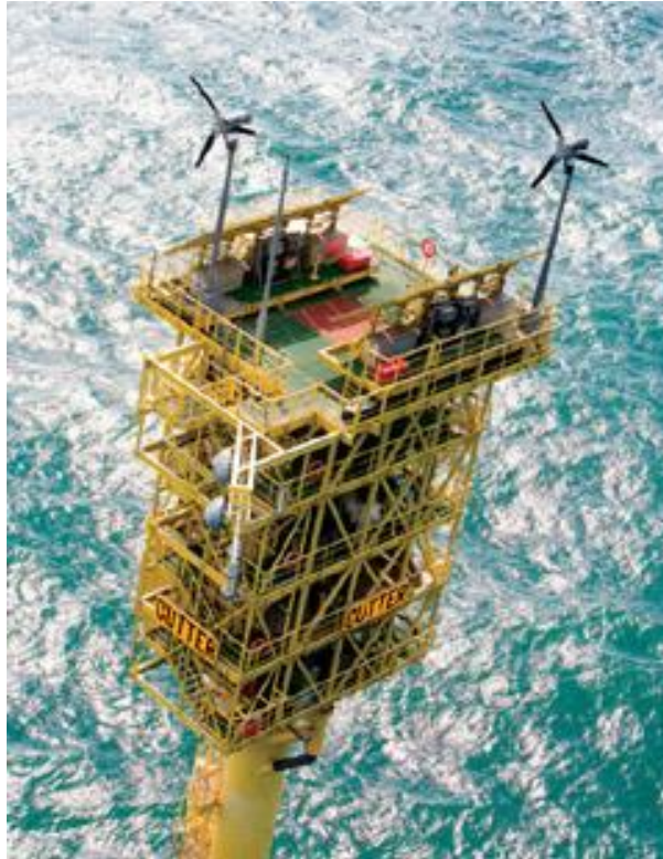
Obrázek 5 – Vrtná souprava na šelfovou platformu, která využívá větrnou a solární energie [20].
