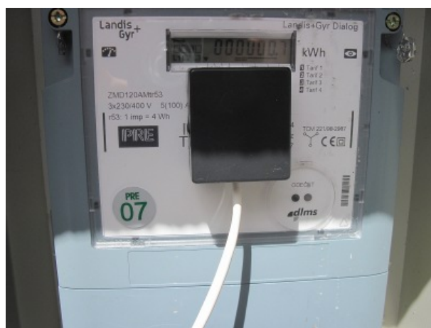
Obrázek 49: Umístění sondy na elektroměru
