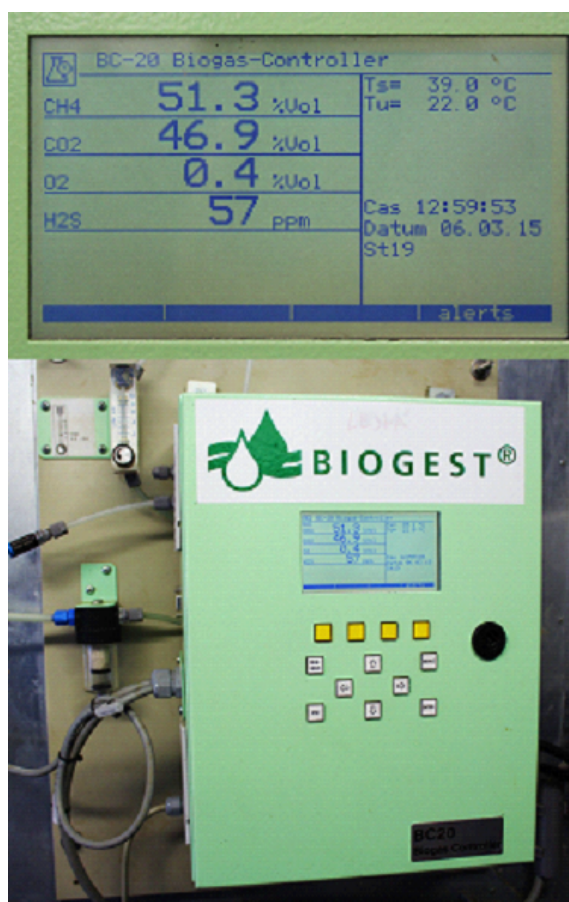
Obrázek 17 : Zařízení pro kontrolu kvality bioplynu, v detailu je vidět aktuální složení bioplynu
