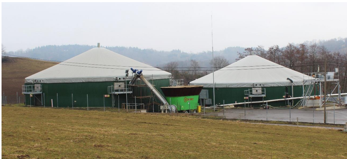
Obrázek 10 : Fermentor (vlevo) a dofermentor
