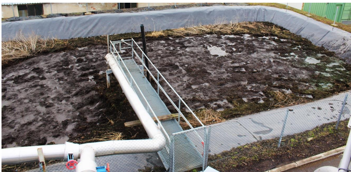
Obrázek 13 : Ukládací laguna pro fugát
