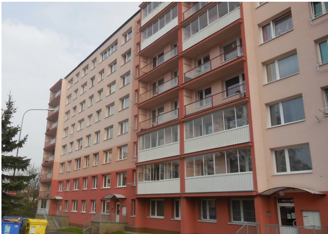
Obr. B 1 Pohled na přední průčelí domu
