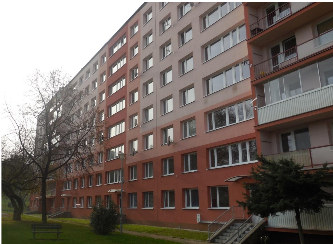
Obr. B 2 Pohled na zadní průčelí domu
