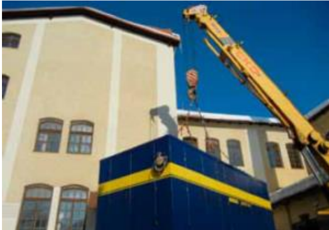
Obrázek 9 instalace kogenerační jednotky v areálu AZ Škoda, Vrchlabí [11]
