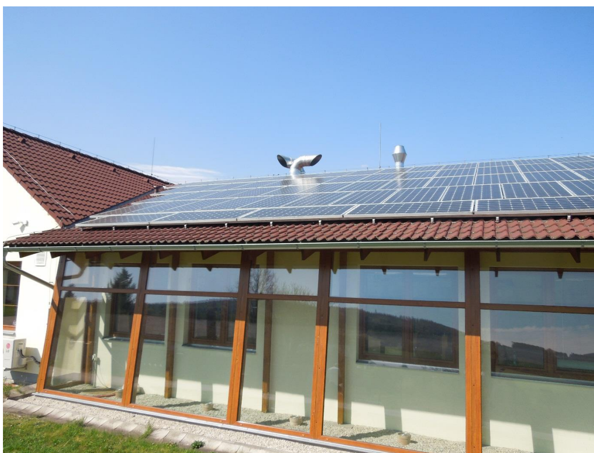
Obr. 15. Střecha bez termokamery 1. část, zastínění
